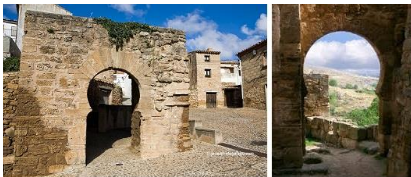
PUERTA CALIFAL Y PUERTA DEL BARRIO
