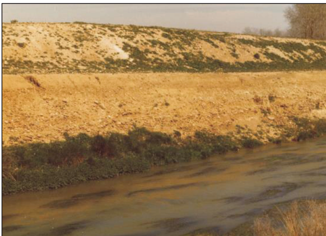
Figura 3: Trinchera del cauce del rio Sequillo.
