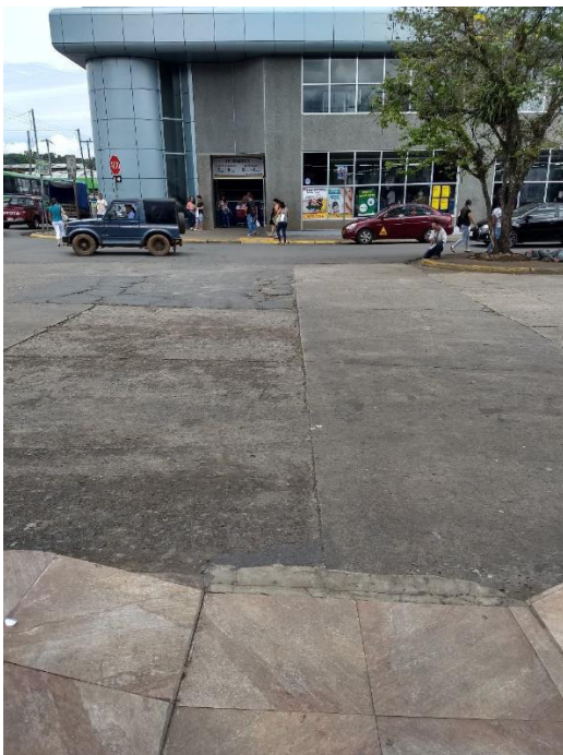
Figura 26. Una de las rampas en el área de los andenes Fuente base de datos del investigador.
