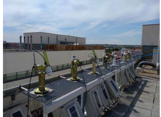
Figura 2.2: Estación de los Cimel-318.
