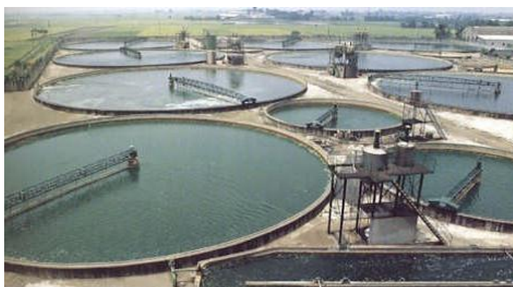
Figura A3.2. Tanques circulares abiertos [Fuente: Cultivo de Chlorella en tanques circulares en Taiwán]
