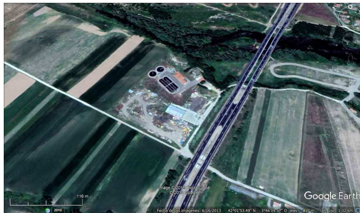
VISTA GENERAL DE LA EDAR
