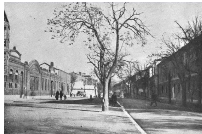
Fig. 29: Visión aérea actual de las calles Chancillería y Gondomar, 2018. Captura de pantalla extraída de Google Maps. Visitado en junio 2018. Fig. 30: Calle Chancillería alrededor de 1910. Imagen extraída de fuente desconocida.
