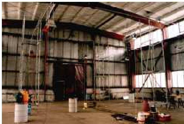
Figura 17. Nave industrial donde se realizó el estudio de los tubos radiantes [8]
