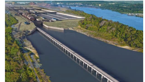
Fig. 33 Ampliación del canal de Panamá a cargo del consorcio GUPC conformado por las empresas Sacyr Vallehermoso (España), Impregilo (Italia), Jan de Nul (Bélgica) y Constructora Urbana S.A. (Panamá)/ Fuente: http://www.sacyr.com/es_es/images/AF_FolletoWeb_Espanol_
