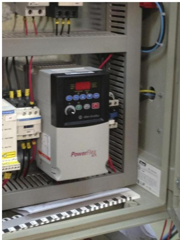
Figura A1.2 Variador de frecuencia PowerFlex 40 de Allen-Bradley.
