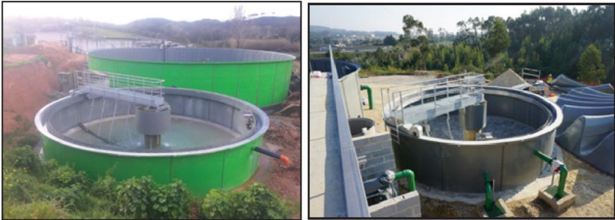
Figura 46: Imagen de decantadores similares
