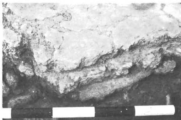
Lám. VI.—Detalle del sistema constructivo de la parrilla a base de capas horizontales de arcilla.
