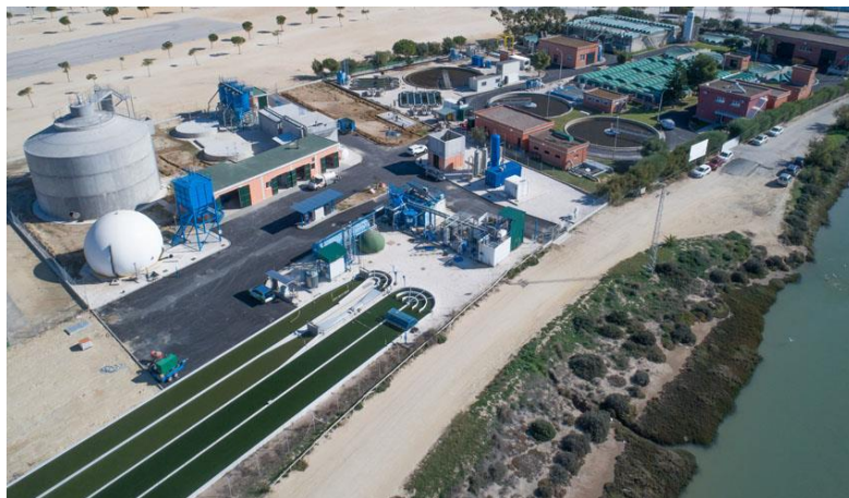
Figura 1. EDAR el Torno, Chiclana de la Frontera. Proyecto ALL-GAS.
