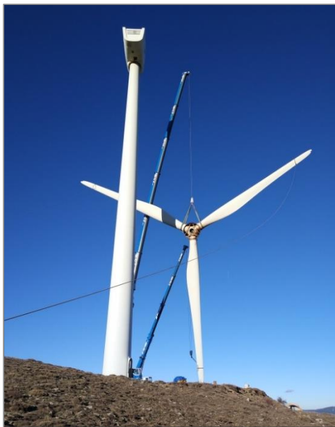
Imágenes 11 y 12: Ascenso y colocación del rotor y las palas.
