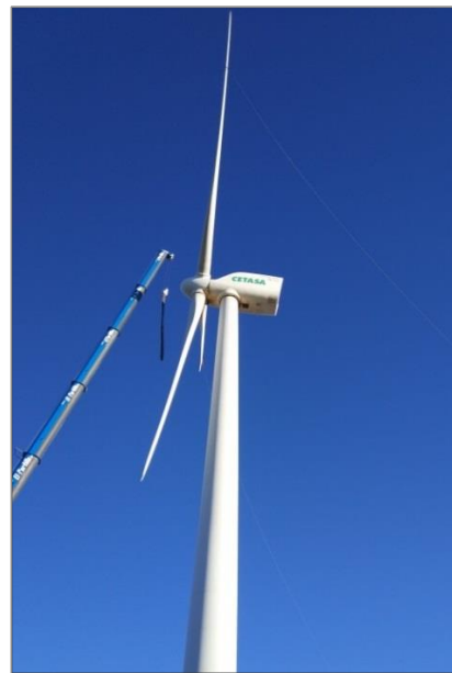
Imágenes 11 y 12: Ascenso y colocación del rotor y las palas.
