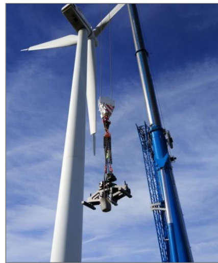
Imagen 13 y 14: “Fixture” Sistema de fijación del eje lento del rotor para su sujeción.
