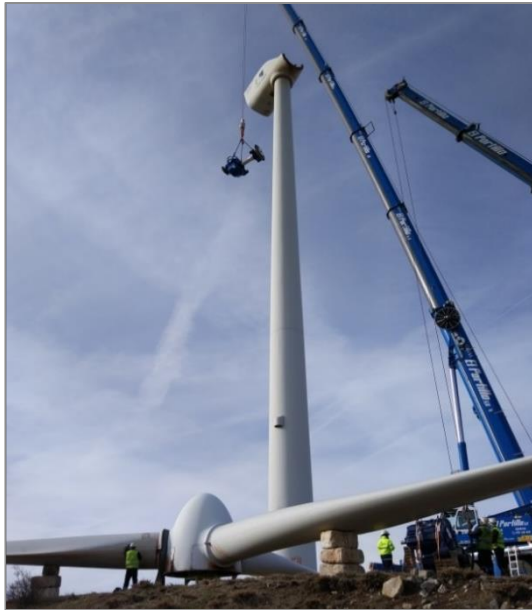
Imágenes 3 y 4: Descenso de la multiplicadora a sustituir junto con el eje lento.
