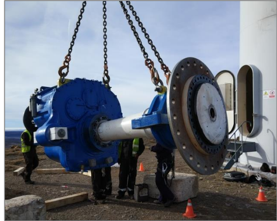
Imágenes 3 y 4: Descenso de la multiplicadora a sustituir junto con el eje lento.
