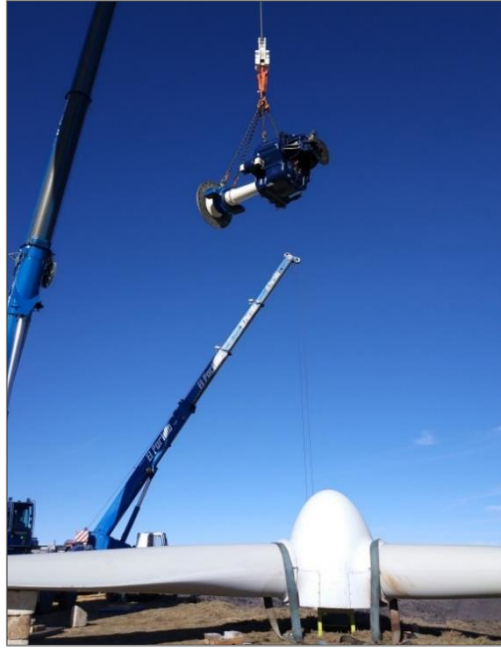
Imagen 10: Ascenso de la multiplicadora nueva con el eje lento ya acoplado.
