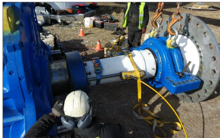
Imagen 5: Desencaje del eje lento de la multiplicadora mediante gatos hidráulicos.
