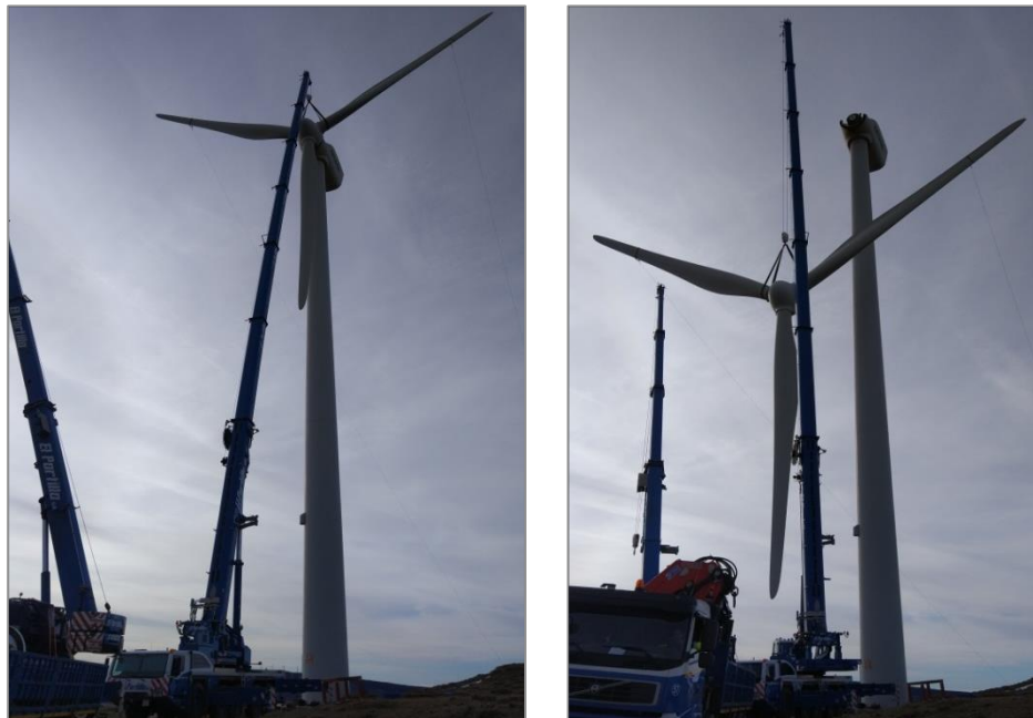
Imágenes 1 y 2: Sujeción de las palas y bajada del rotor con las palas al suelo.
