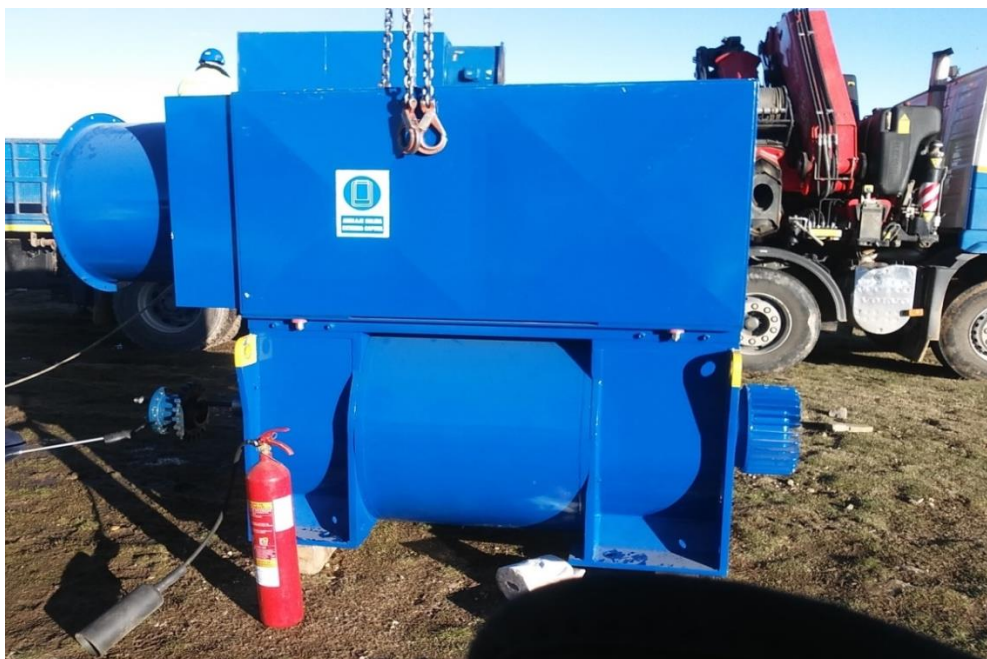
Figura 38: Realizando las operaciones de comprobación del generador nuevo. Elaboración propia.
