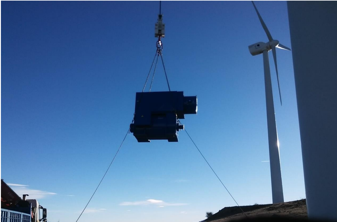
Figura 39: Inicio del izado del generador nuevo. Elaboración propia.
