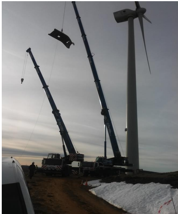
Figura 36: Foto en el momento de descenso de la capota de la góndola. Elaboración propia.
