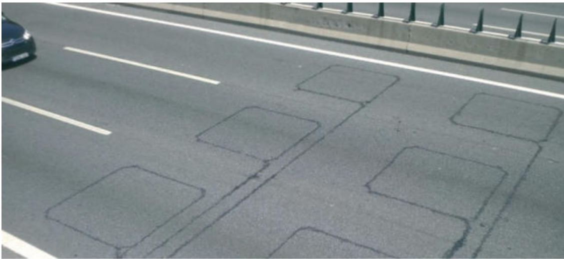
Ilustración 2. Ejemplo de aros inductivos integrados en la carretera
