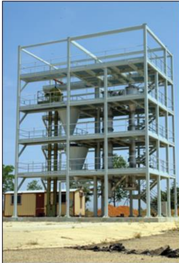
Figura 2.15. Vista general de la planta piloto de gasificación de lecho fluidizado circulante.
