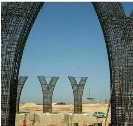
Etapa de hormigonado de soportes en un viaducto.
