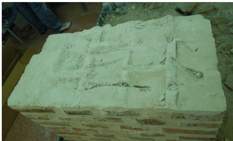
Imagen 251. Detalle de un tendel de argamasa en el proceso de desmontaje de los 4 muros
