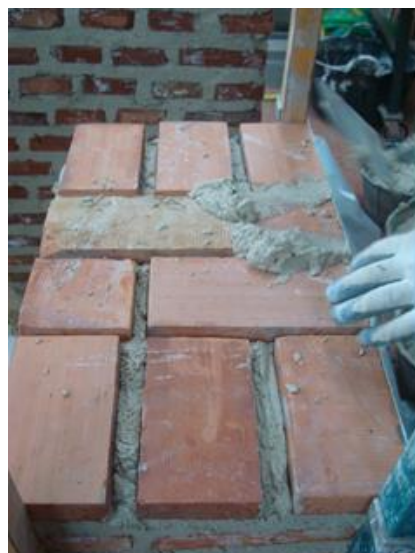
Imágenes 178 y 179. Proceso de construcción de la balsa y de los muros.
