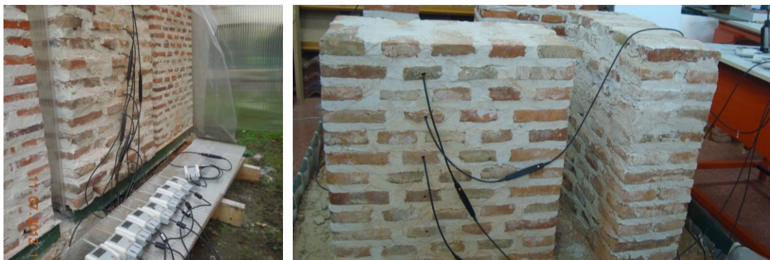
Imágenes 83 y 84. Detalle de los extremos de las sondas introducidos en perforaciones de diferentes probetas de fábricas de ladrillo en las juntas de argamasa y en los ladrillos.
