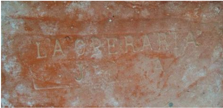
Imagen 40. Detalle de ladrillo de tejar "La Operaria". Obsérvese la estampación y las señales del paso de los dedos del artesano
