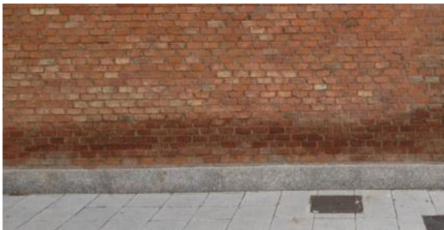
Imagen 71. Fábrica de ladrillo de tejar macizo colocado a tizón con presencia de humedad capilar. Se aprecia claramente la marca del frente húmedo
