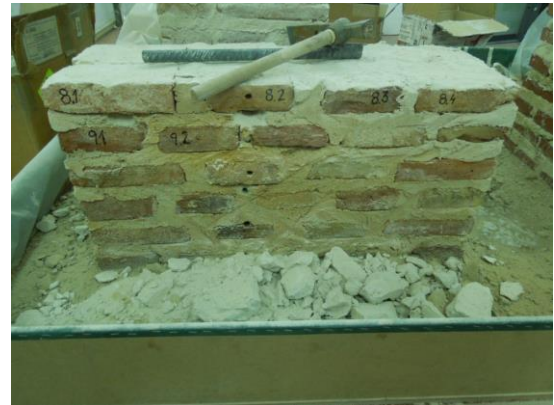
Imagen 253. Desmontaje del muro con los ladrillos numerados
