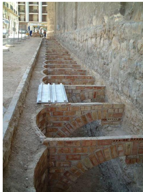
Imágenes 11 y 12. Detalle de ejecución de cámara bufa y estado final antes de proceder a su cubrición 53
