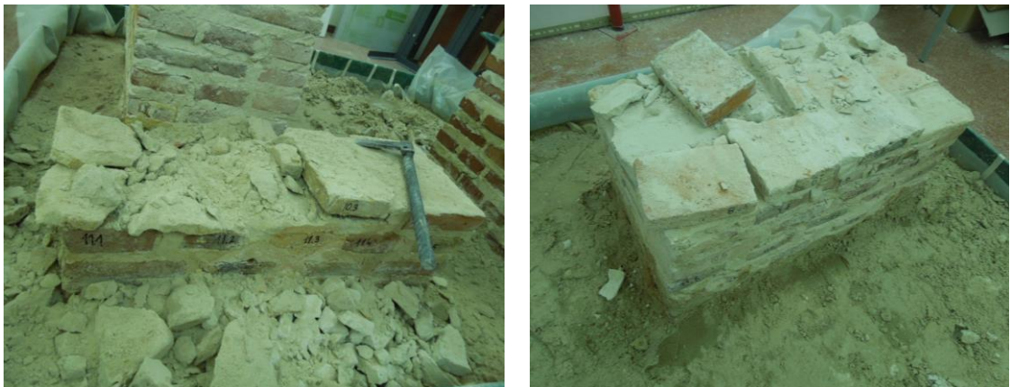
Imágenes 91 y 92. Momentos del desmontaje de los dos muros de ladrillo de tejar
