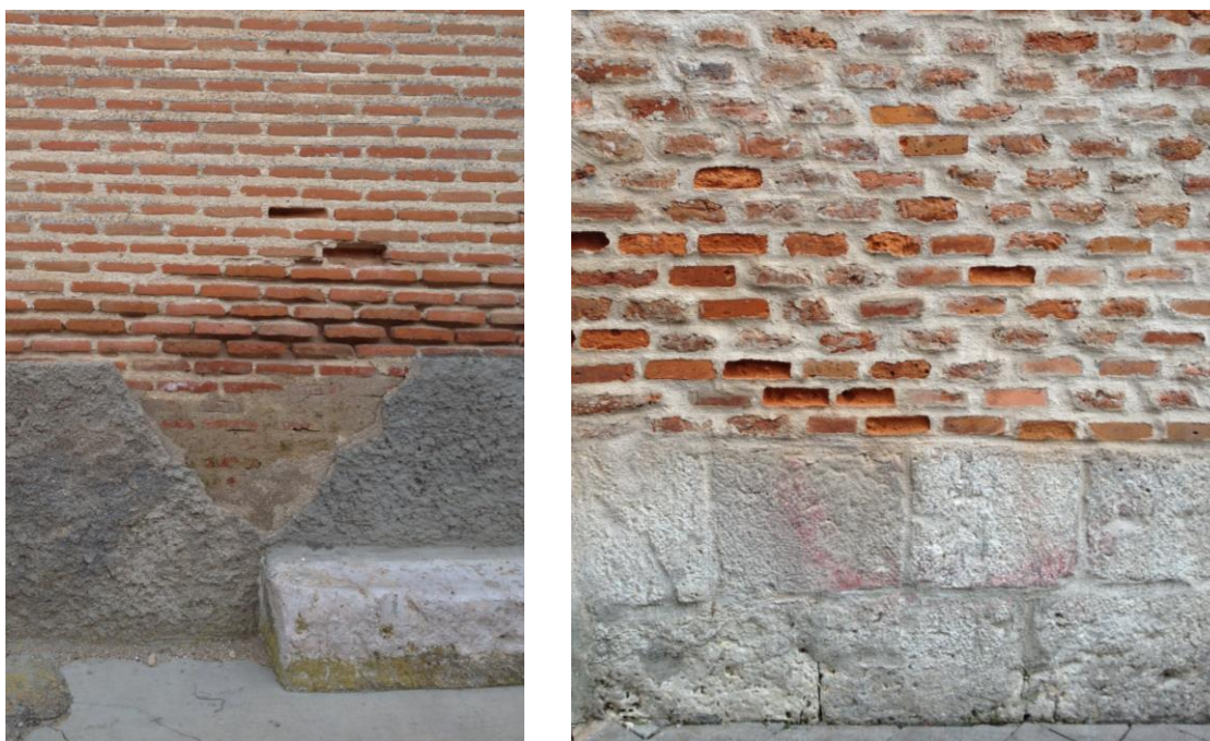
Imágenes 66 y 67. Fábricas similares a las estudiadas. Ejecutadas con ladrillo antiguo de tejar macizo y con juntas gruesas de argamasa de cal. Se aprecia el deterioro producido por la ascensión de agua por capilaridad, y por las incorrectas soluciones ejecutadas para su reparación.
