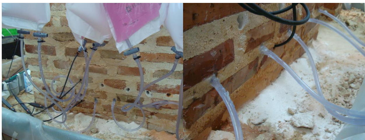
Imágenes 180 y 181. Proceso de hidrofugación de los muros de asta y media
