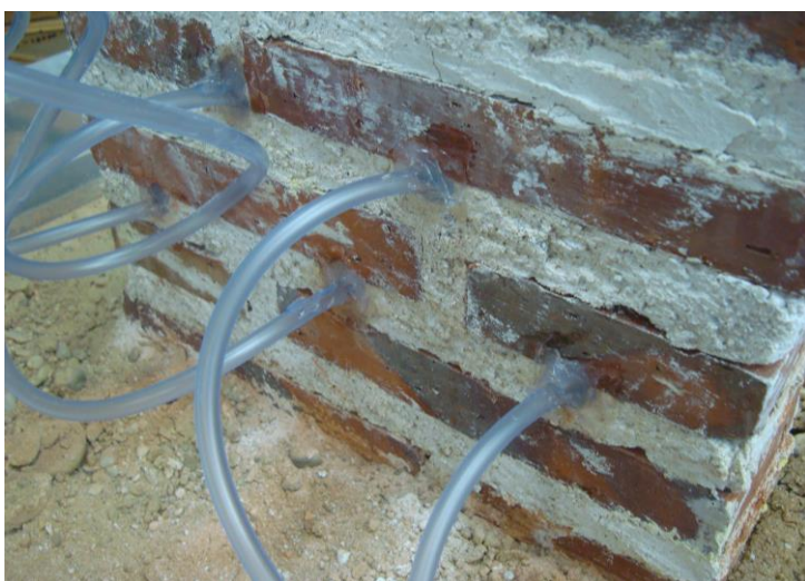
Imágenes 169 y 170. Sellado de las perforaciones y proceso de hidrofugación por gravedad
