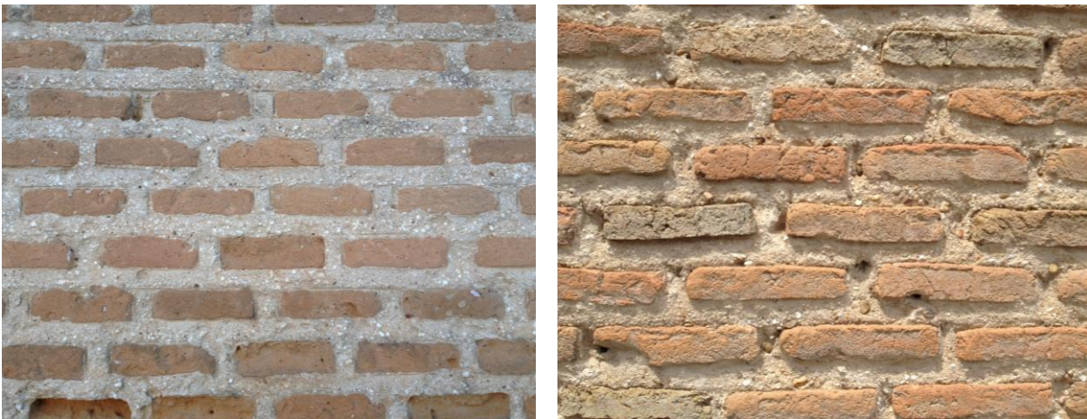
Imágenes 60 y 61. Fábricas de ladrillos de tejar con juntas de argamasa con distintas configuraciones
