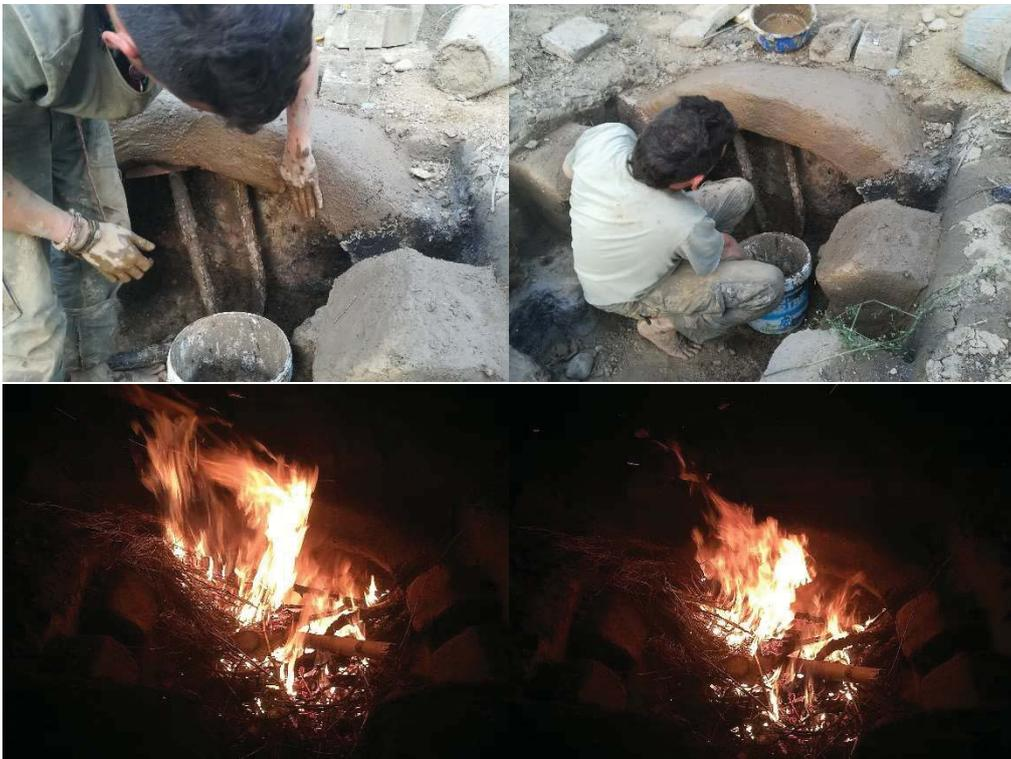
Fig. 93. Construcción del primer arco: Manteados y quemado.
