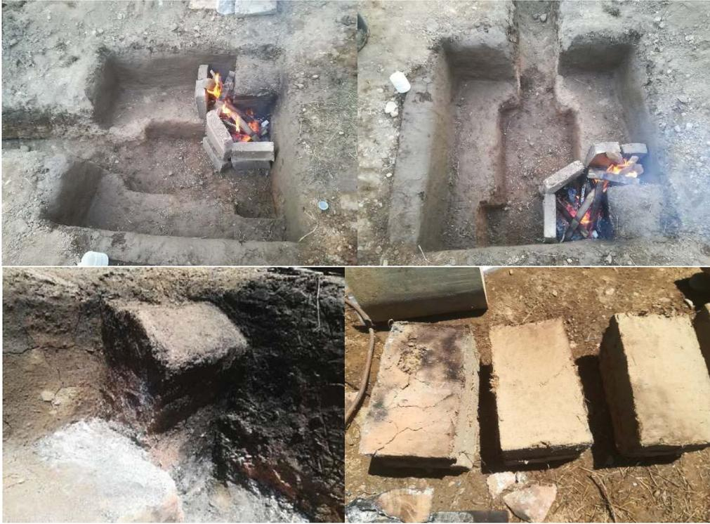
Fig. 92. Construcción de las bases de los arcos: Quemado y secado de adobes.
