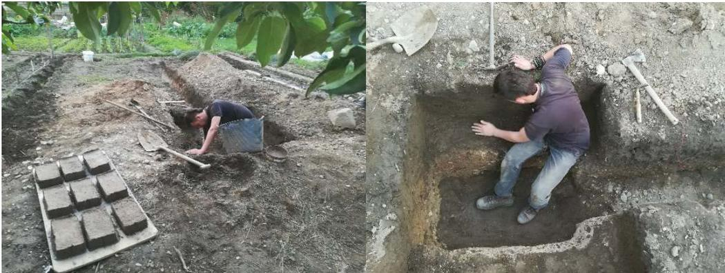
Fig. 90. Revestimiento de las paredes y el suelo de la cámara de combustión con tierra limosa (Objetivo: Taponar los orificios y crear paredes lisas para mejorar el comportamiento térmico de la caldera).
