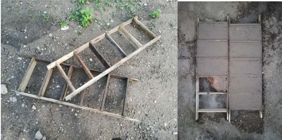
Fig. 94. Elaboración de material constructivo: segunda fórmula; molde múltiple y elaboración de adobes (8 de 10 posibles)
