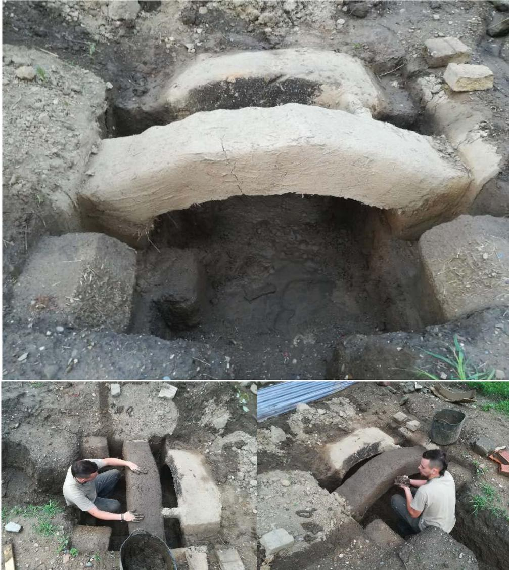
Fig. 96. Construcción del segundo arco: Manteados.
