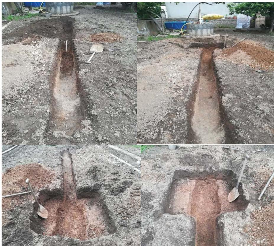
Fig. 87. Construcción del corredor de acceso y la cámara de combustión.
