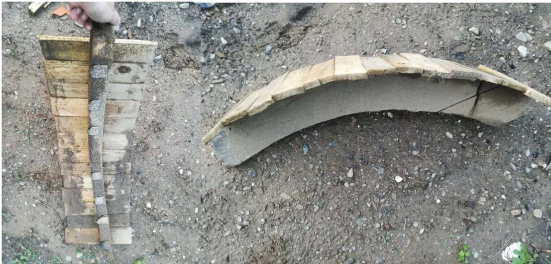
Fig. 95. Encofrado de madera: Sustentación para la construcción del arco central. (Madera curva de barril con 13 tablas para la correcta colocación de los adobes).
