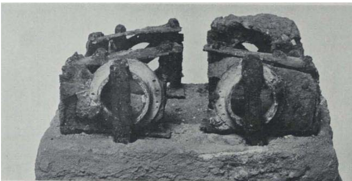
Restos pertenecientes a la catapulta de Ampurias, comprenden el bastidor y las placas de hierro pertenecientes a la parasticae y tabulae , además de 4 modiolis donde irían encajadas sus respectivas epizygis . Fuente: (Batz, 1994).
