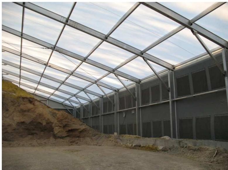
**Figura X.14.** Fotografía de una cubierta de adsorción autoregenerante en una planta de compostaje de fangos
