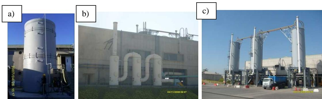
**Figura XI.10.** Sistemas para disminuir la molestia odorífera en la EDAR La Farfana: (a) Biotrickling de la cámara de mezcla. (b) Lavador químico en la zona de centrifugas. (c) Sistema de carga de lodos.
