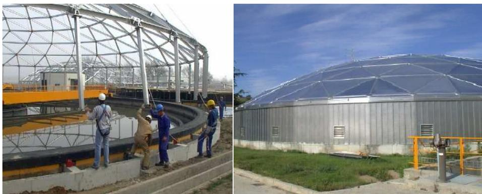
**Figura VII.2.** Cubiertas de nivel alto (cortesía de JSF hidráulica S.L).
