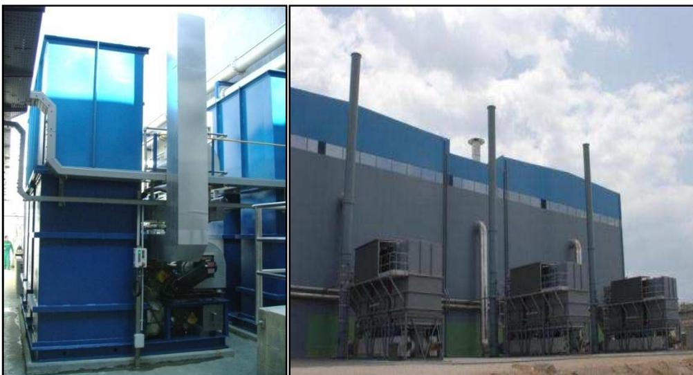
**Figura X.12.** Izda.: 2 RTO en el tratamiento de olores de la planta de secado térmicos de fangos de Barcelona. Dcha.: 3 RTO en el tratamiento de olores de la planta de secado térmicos de fangos de Grecia
