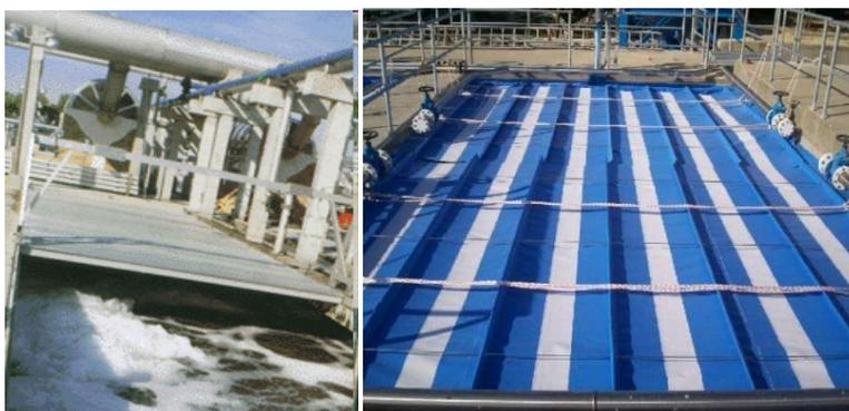
**Figura VII.1.** Cubiertas de nivel bajo (cortesía de JSF hidráulica S.L.)
