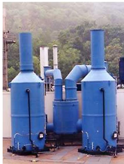
**Figura X.1.** Sistema de absorción a contracorriente, esquema (izda.) y fotografía (dcha.).
