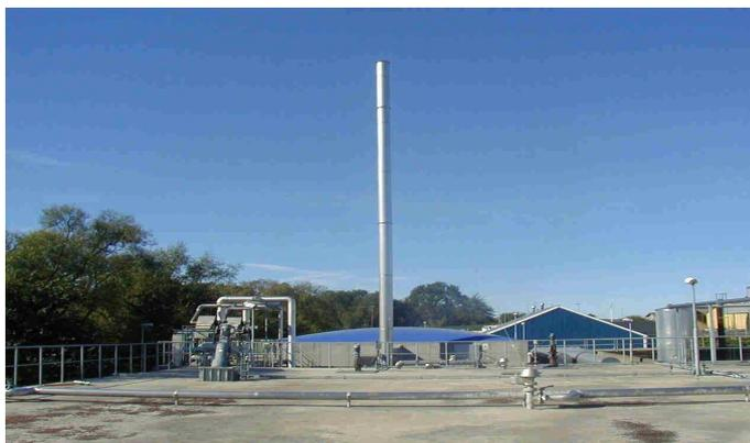
**Figura X.6.** Filtro biológico avanzado en el secado de fangos de una EDAR.
