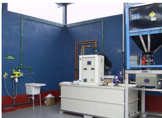
**Figura VI.2.** Equipo de preparación y dosificación de permanganato.
