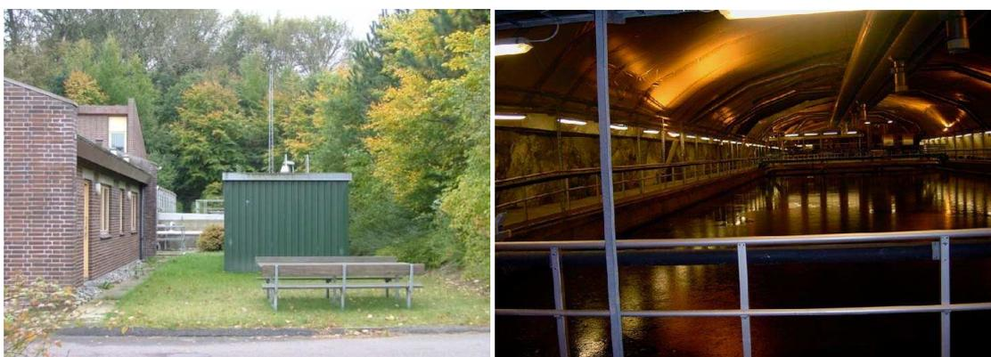
**Figura X.7.** Izquierda: Filtro Biológico Avanzado en el tratamiento del aire de la zona de pretratamiento de una EDAR (Dinamarca) Derecha: Filtro Biológico Avanzado soterrado en el tratamiento de aire de pretratamiento y de decantadores de una EDAR (Noruega).
