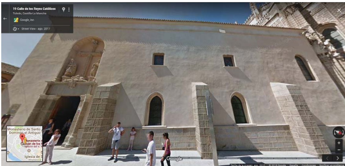
Fig. 32. Estado actual de la sacristía y la Puerta del Pelicano.
