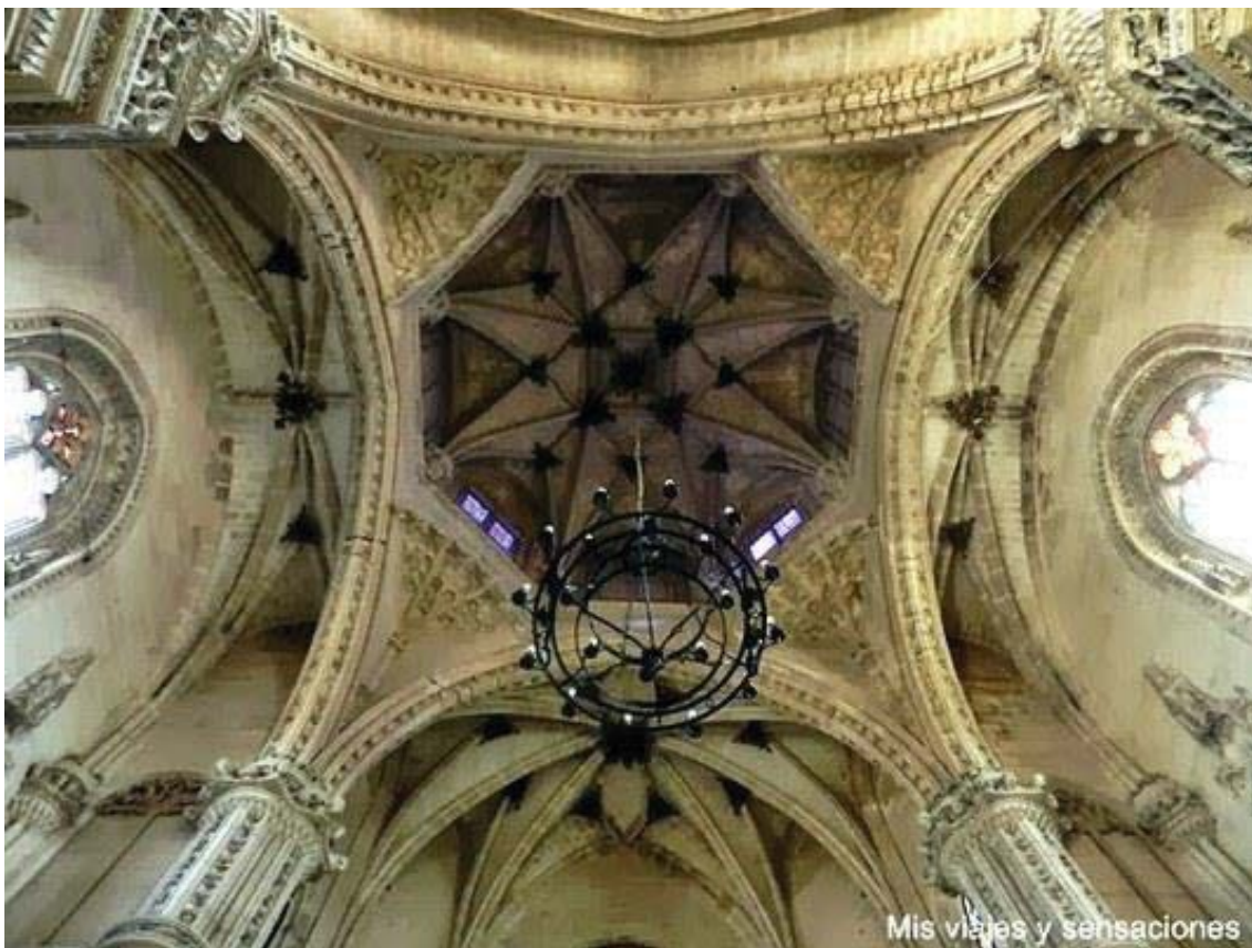
Fig. 16. Cimborrio visto desde el interior de la iglesia.
