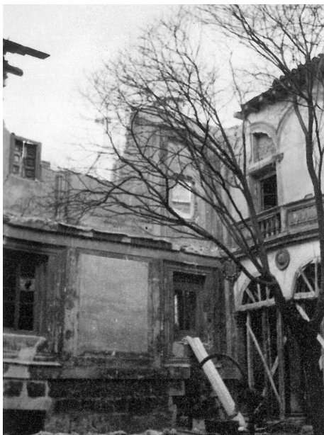
2. Obras de restauración en el patio.
