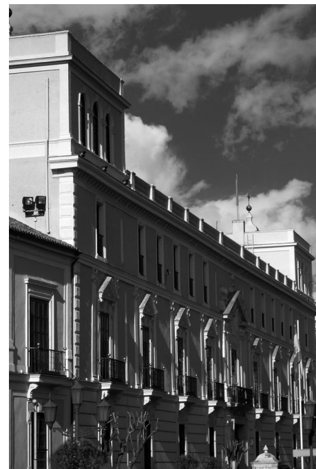
11. Palacio Real. Fachada principal.
