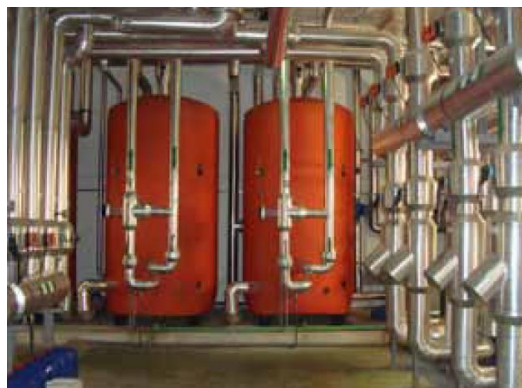
Figura 8: Depósitos de acumulación calor sensible [18]
