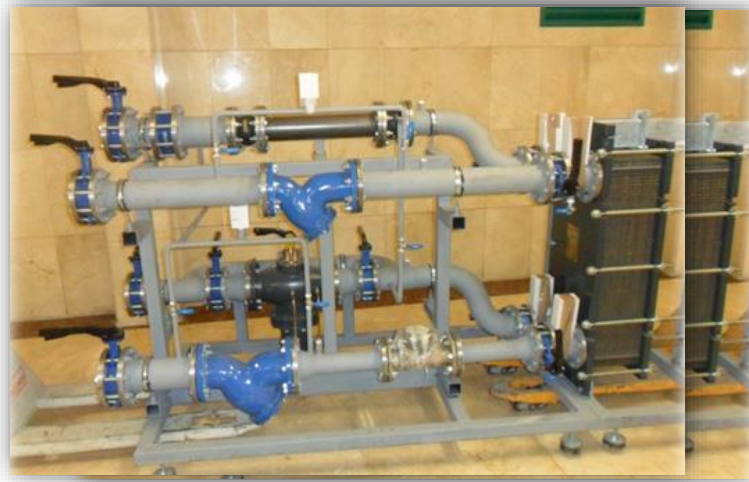
Figura 10: Subestación con intercambiador de placas, Valladolid [26].
