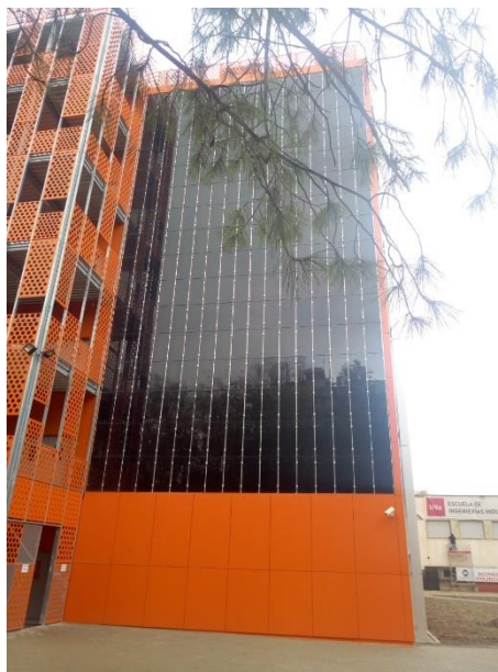
Ilustración 10. Fachada sureste IndUva
