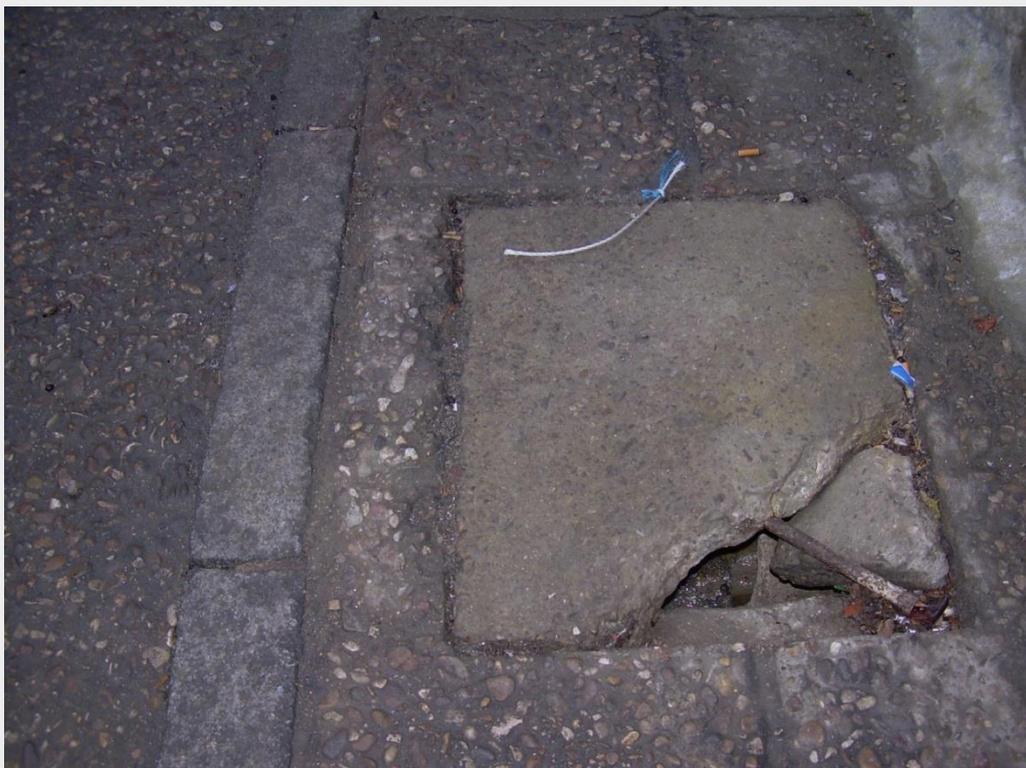
*Tapa de la red de alcantarillado rota en calle Cóndor, con las aguas fecales desalojadas de un edificio al descubierto. Fotografía tomada el 23-3-2015.*
