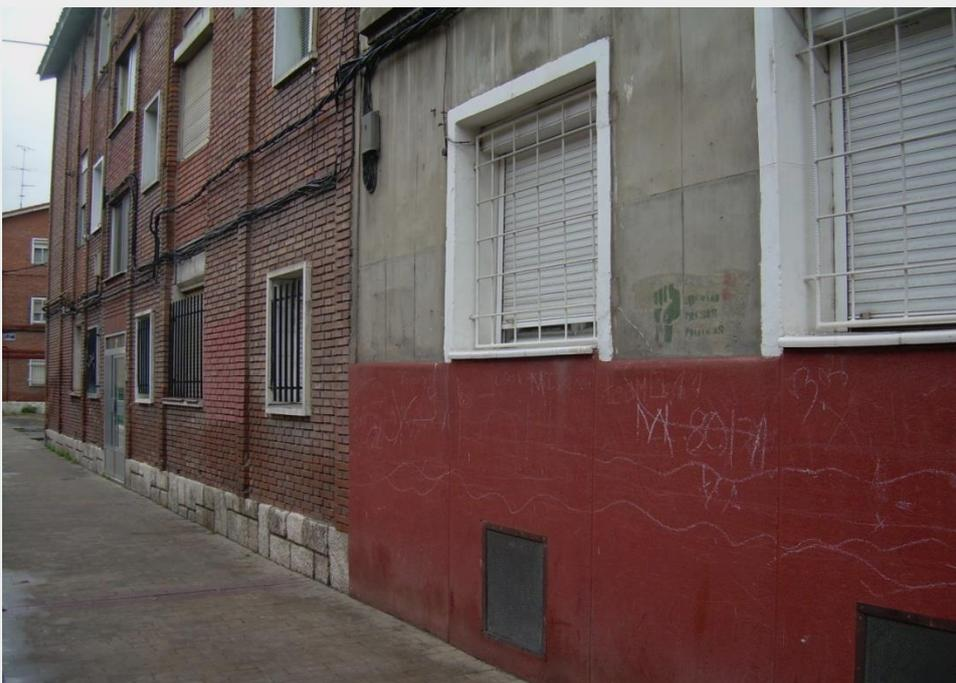
*Comparación entre un edificio del conjunto analizado y otro adyacente en calle Villábañez, que permite comprobar como las viviendas al fondo de la imagen están a nivel del suelo, sin el forjado sanitario que se observa bajo las otras viviendas. Fotografía 23-3-2015.*
