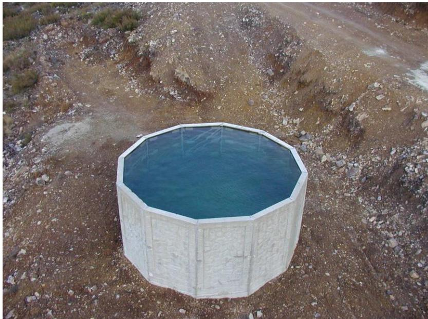
Foto 3: Depósito prefabricado de 50.000 litros de capacidad.
