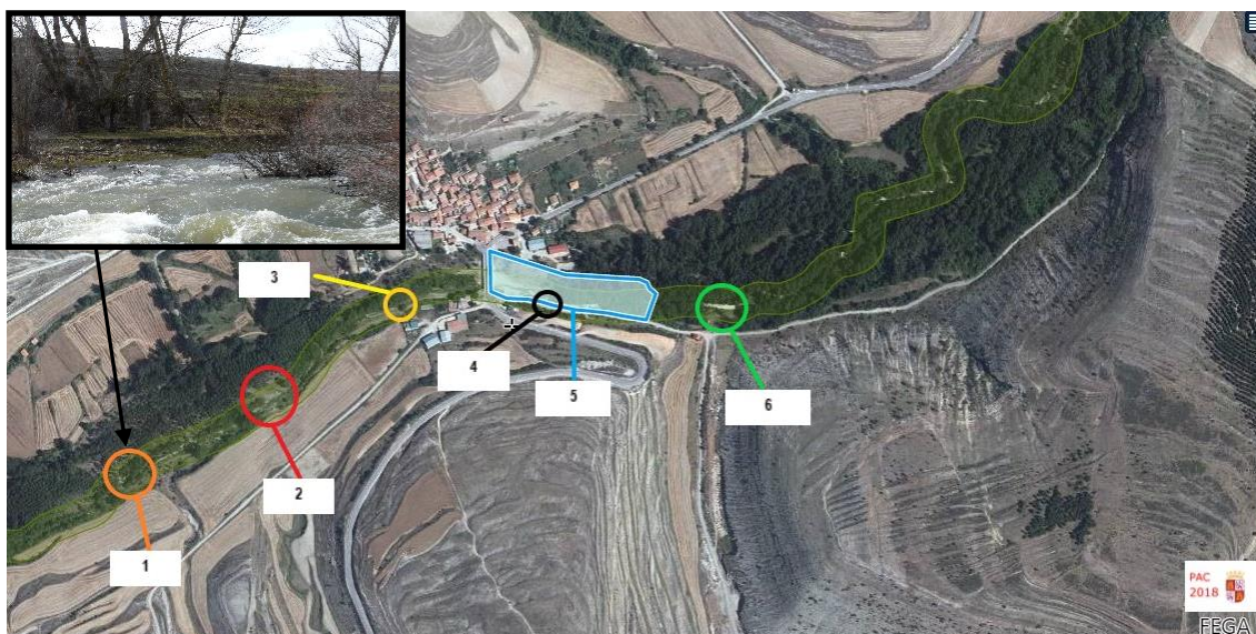
Figura 3. Talud nº1 a restaurar (muro Krainer). Fuente: SIGPAC, 2018.
