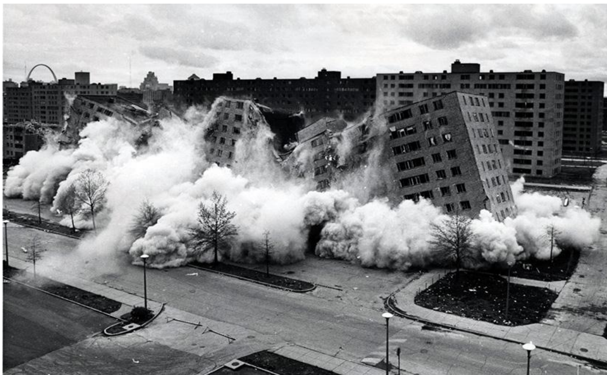
Imagen 23: Demolición del conjunto residencial Pruitt-Igoe en Sant Louis (1974) Fuente: https://urbancidades.wordpress.com/2014/03/29/pruitt-igoe-el-fracaso-politico-de-la-arquitectura-social-st-louis-missouri-1941-1974/
