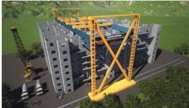
Figuras 2, 3 y 4: Aplicación del Contour Crafting en la edificación a diferentes escalas. Obtenidas de: http://contourcrafting.com
