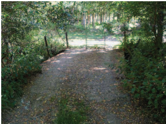
Foto 5: Puente sobre el arroyo Barrancondo
