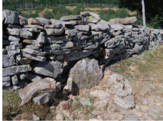
Foto 28: Detalle de los cerramientos próximos al camino
