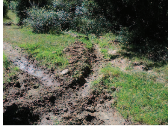
Foto 10: fin del tramo entre paredes de mampostería
