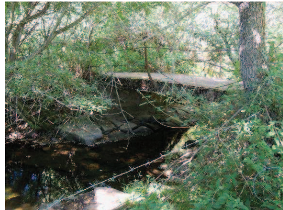
Foto 6: vista del puente aguas abajo
