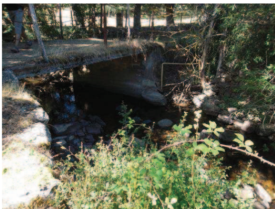
Foto 9: Vista del puente desde aguas arriba
