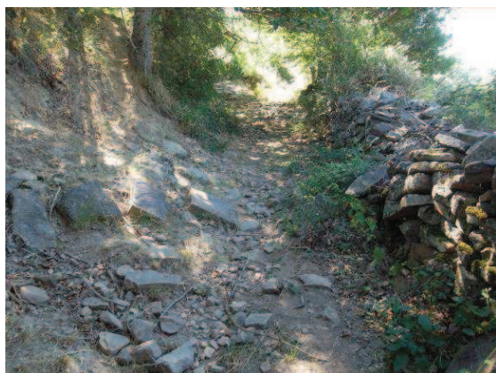
Foto 15: Cerramiento de pared en la margen derecha y talud en margen izquierda, inicio desnivel
