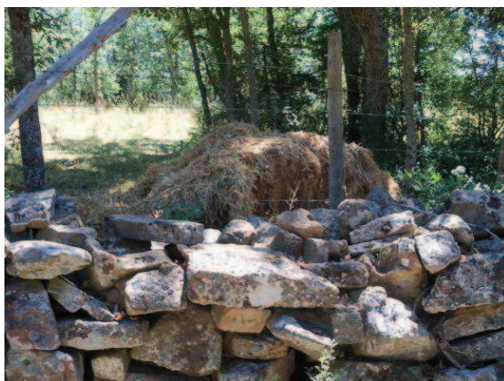
Foto 90: Detalle del cierre en margen izquierda
