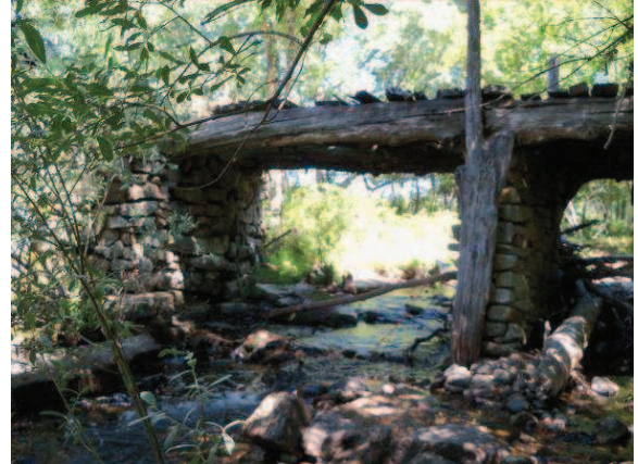
Foto 123 : Vista aguas abajo
