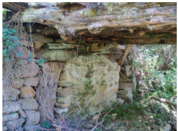
Foto 121 : Detalle del apoyo de las Vigas
