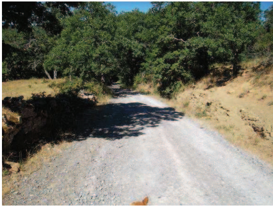
Foto 5: Tramo de mayor pendiente
