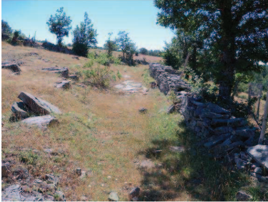
Foto27: Cerramiento margen derecha del camino
