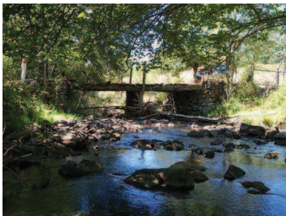
Foto 120: Vista del Puente de madera
