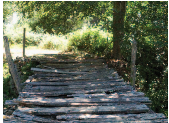
Foto 125 : Estado del Tablero actual. Fin ruta 2 y fin obra proyecto
