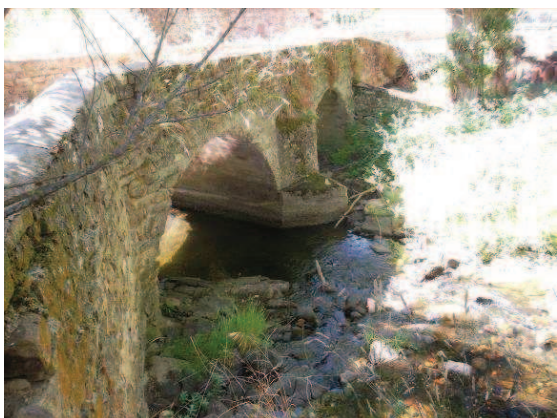
Foto 9: Vista del puente desde aguas arriba
