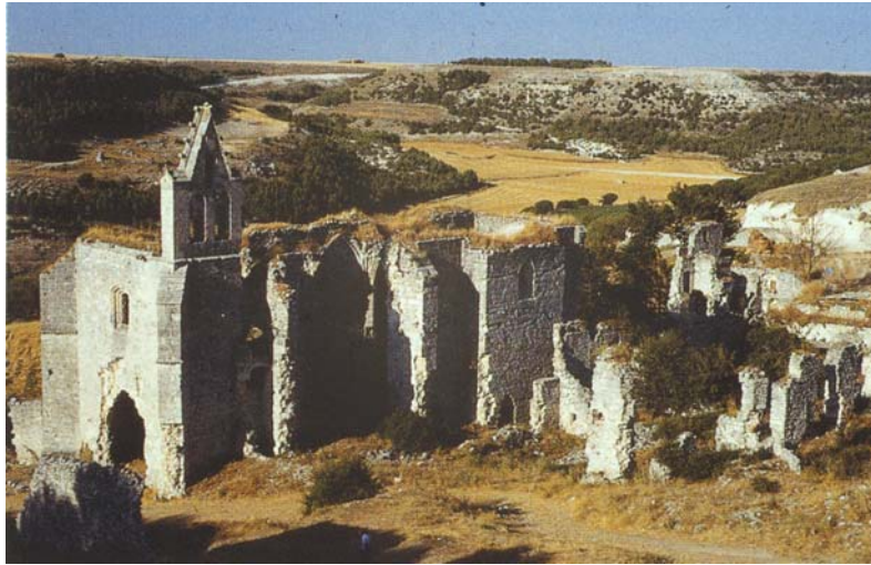
Ruinas del Monasterio de Jerónimos de Santa María de Armadilla en Cogeces del Monte. Valladolid. Construido en las mismas fechas y de factura muy similar al de guijosa.
