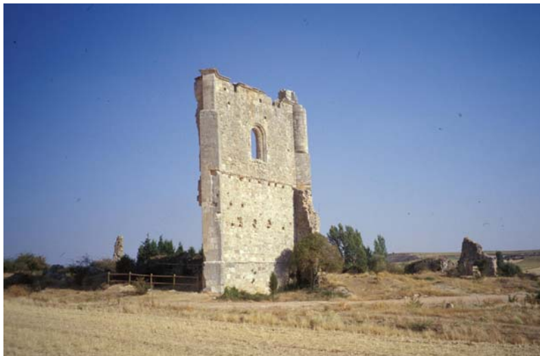
Estado actual de las ruinas de Guijosa. Muro oeste, soporte del coro.
