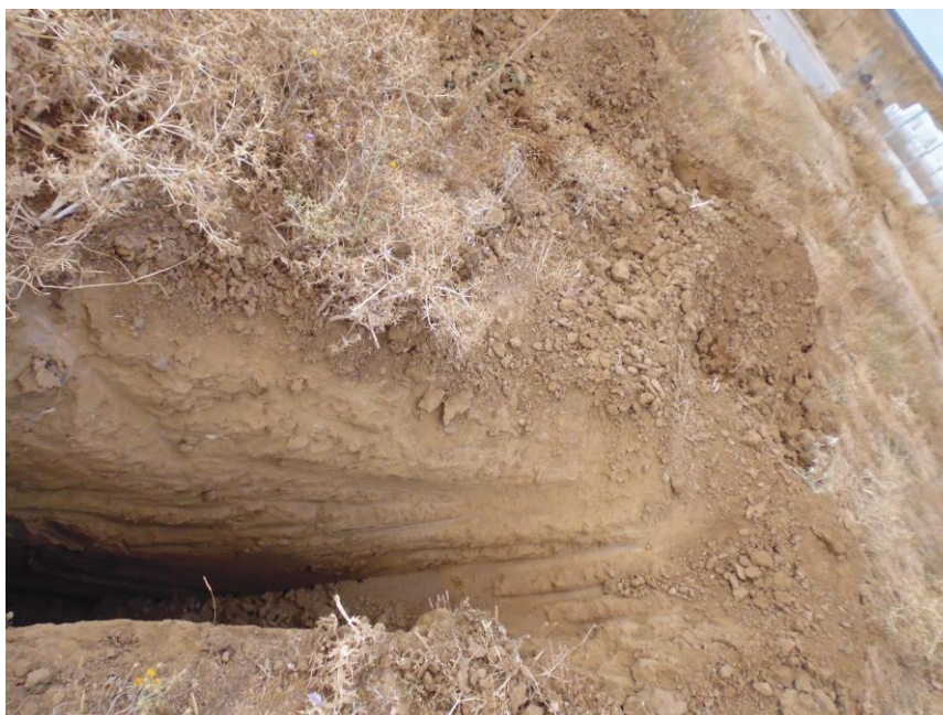
Ilustración 3. Cata 2: Firme compacto a partir de 30 cm, bajo capa vegetal.
