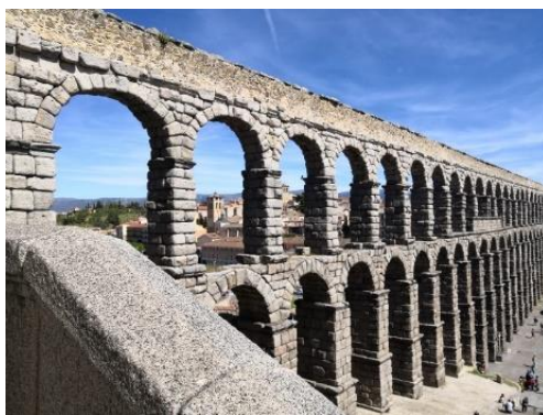
Fig. 4. Acueducto de Segovia Fuente: autora (5 de mayo de 2019).
