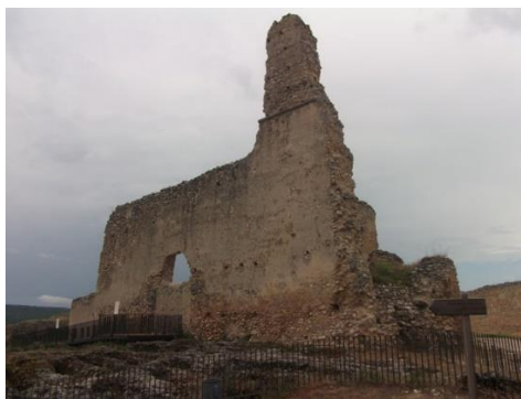
Fig. 18: vista de la iglesia de San Martín en Fuentidueña. Segovia
