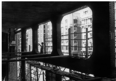
17 Vigas Vierendeel de fachada del Edificio Carrión. Vista Interior.
