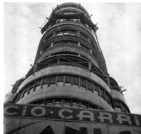
15 Fachada curva del Edificio durante su proceso de ejecución.
