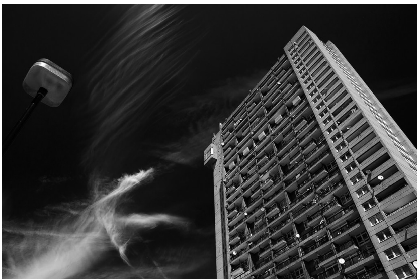
6 Trellick Tower Londres fotografía de Karl J. Shaw 2011. [ http://commons.wikimedia.org/wiki/File:Trellick_Tower_photographed_from_Elkstone_Road ]
