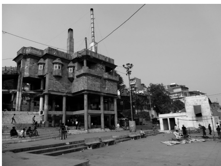
46 Incineradora eléctrica. Ghat Harishchandra, Benarés.
