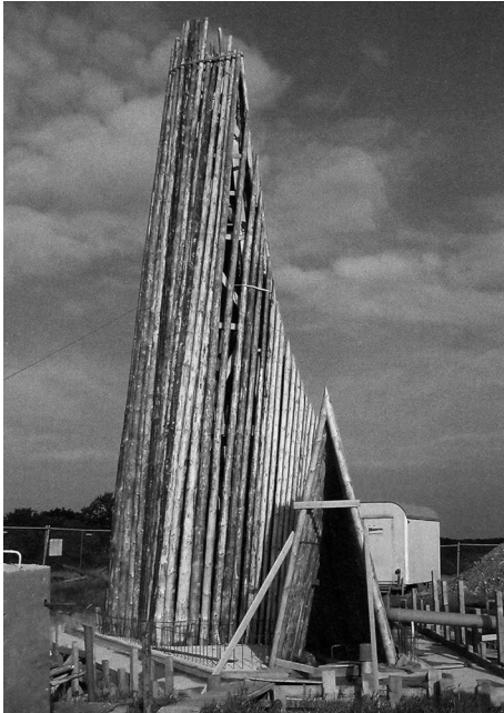
7 Peter Zumthor. Bruder Klaus Kapelle construcción. Mechernich - Wachendorf, Alemania. 2007.
