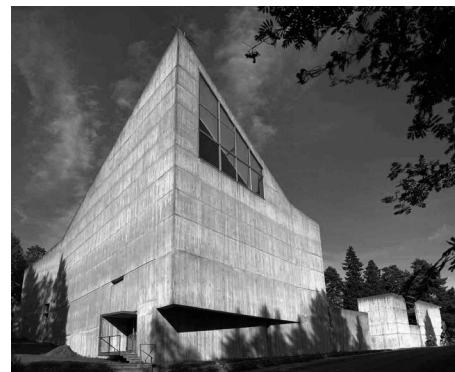
7 A. Ruusuvuori. Exterior de la Iglesia de Huutoniemi en Vasaa (1961-1964). [Autor fotografía: Óscar M. Ares]
