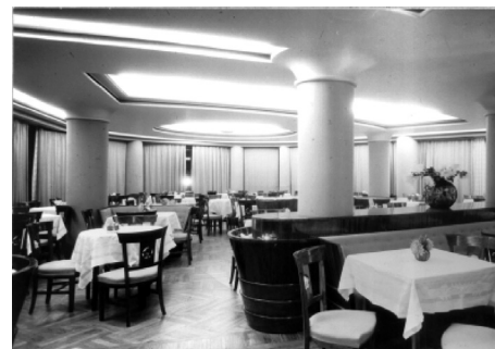
26 Vista del comedor del hotel del Edificio Carrión.
