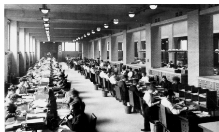
4 Grupo A de pedidos por correo, ala occidental de la planta principal (baja). [Jack Quinan. Frank Lloyd Wright's Larkin Building. Myth and Fact ]
