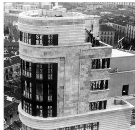
20 Trabajos de catería recién terminados en el torreón del Edificio Carrión.
