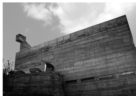
1 Muro norte del monasterio Sainte-Marie-de-la Tourette en Eveux-sur-Arbresle. Le Corbusier, 1957-1960. [Foto Dpto. Teoría y Proyectos. Uva.]
