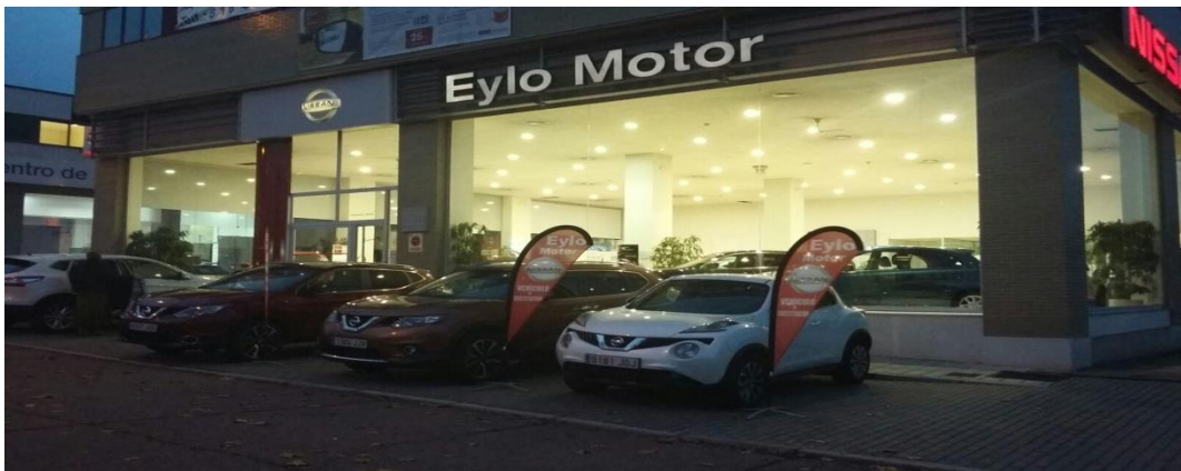
Instalación EYLO Motor S.L (Fuente: Google Imágenes)
