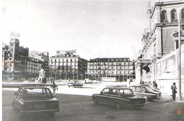
Fig. 6.28. Imagen de la plaza con el aparcamiento ya en funcionamiento, sin arbolado y aun con coches en la superficie (1980). Véase Anexo 1.
