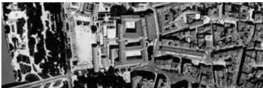
Fig. 6.47 Vista aérea del 58 muestra el arbolado existente en la plaza de San Benito. Véase Anexo 1.
