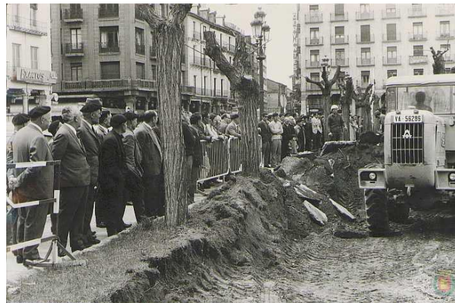
Fig. 6.27 Comienzo de las obras del parking en 1971. Véase Anexo 1.
