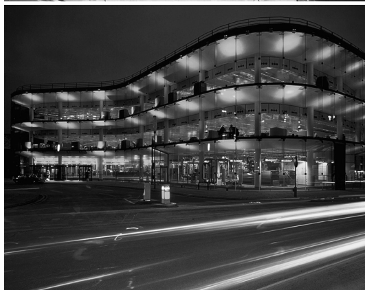
Fotografías exteriores del edificio Willis Faber.
