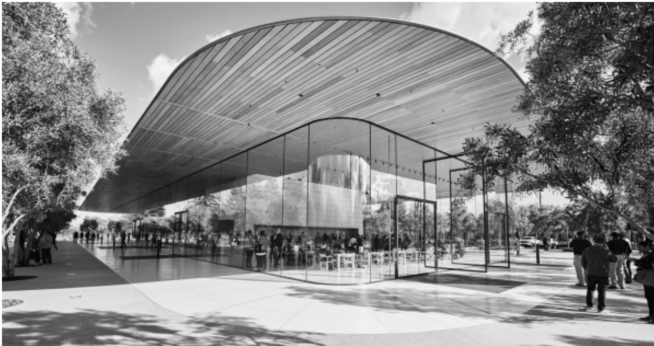
Arriba, fotografías de la cubierta del edificio y su implantación en campus
