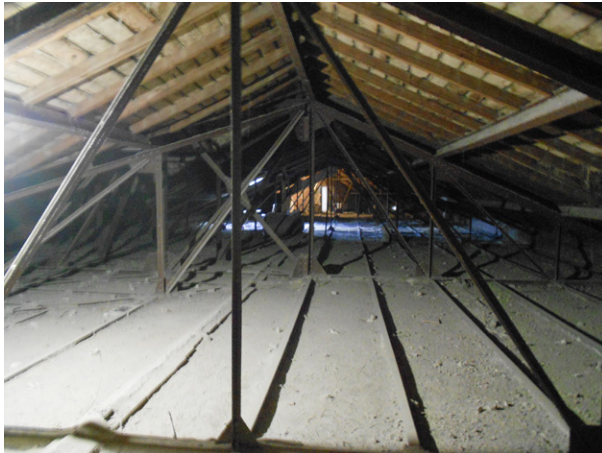
Figura 4.2.4. Imagen general del bajocubierta y cerchas metálicas.
