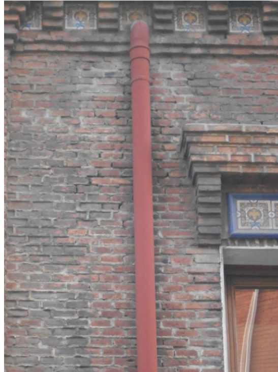
Figura 4.3.4. Conexión de canalón con bajante.
