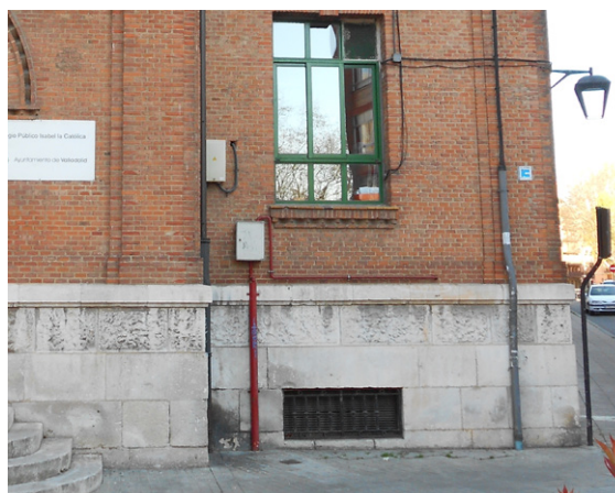
Figura 4.4a.12. Zócalo y fachada principal en 2019.
