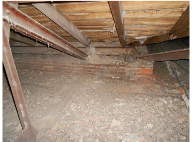
Figura 4.2.5. Encuentro de la cercha metálica con el muro de fábrica.
