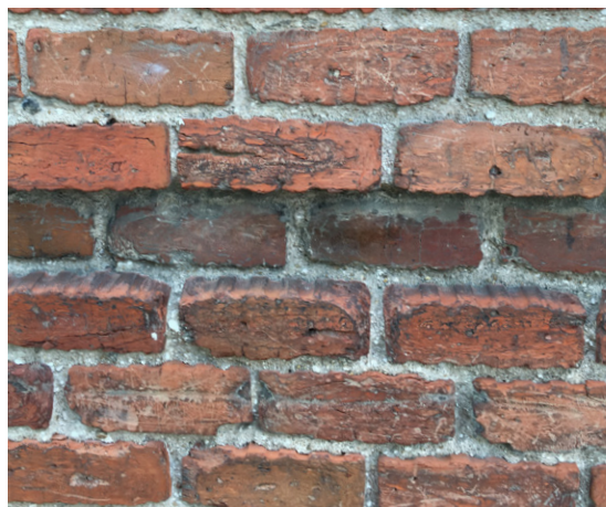
Figura 4.6.6. Lavado de junta en ornamento.
