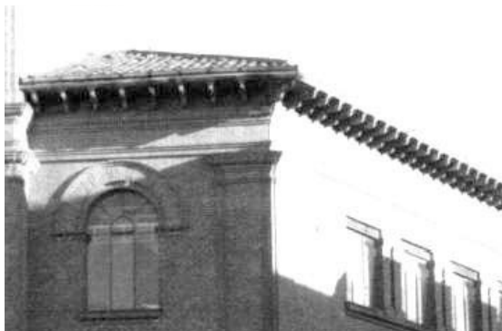
Figura 4.4a.6. Alero sin canalón ni bajantes antes de 1985. Fotografía del archivo de Valladolid.
