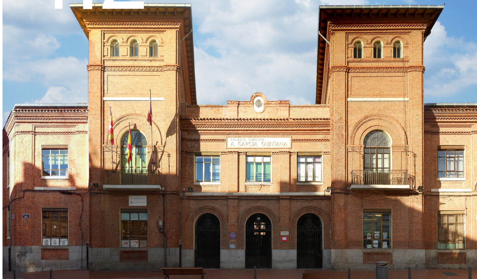
Figura 4.2.1. Fachada principal del colegio.
