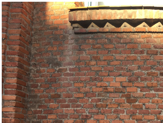
Figura 4.4a.10. Rastro de evacuación de agua por el lateral.
