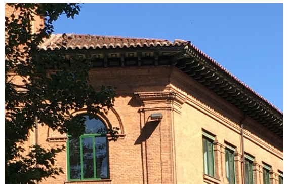
Figura 4.4a.7. Alero con canalón oculto y bajantes en 2019.
