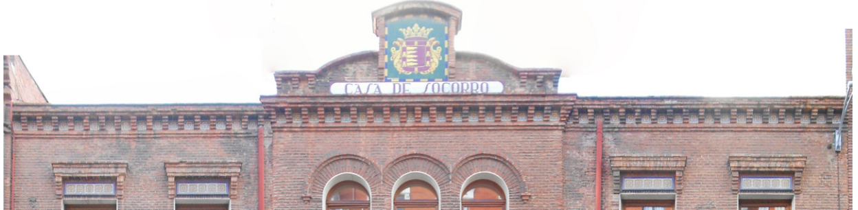
Figura 4.3.11. Suciedad de la zona superior.
