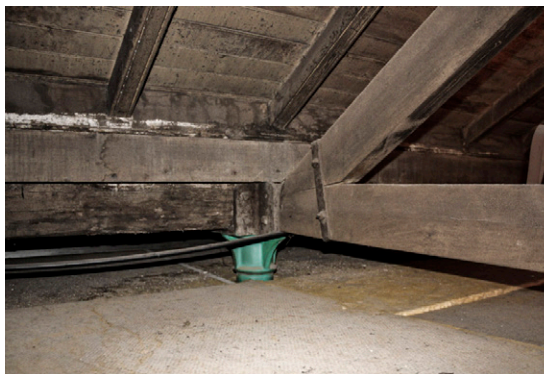
Figura 4.1.6. Apoyo de la cercha en pilar de hierro. http://arquitecturava.es/proyectos-valladolid/antigua-fabrica-de-tejidos-y-sacos-de-yute (2019).
