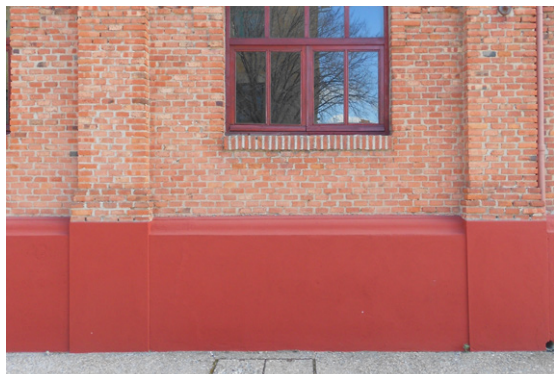
Figura 4.1.5. Fachada de ladrillo y zócalo de hormigón. Fotografía propia.
