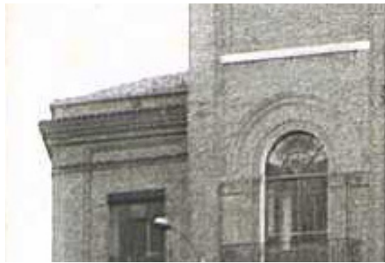
Figura 4.2.6. Cornisa en 1976. Fotografía del archivo de Valladolid.
