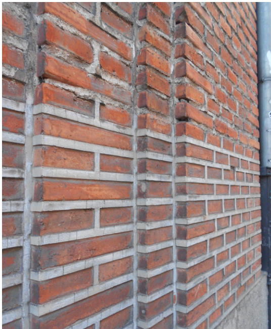
Figura 4.2.22. Posible nueva zona rejuntada en contraposición con la antigua.
