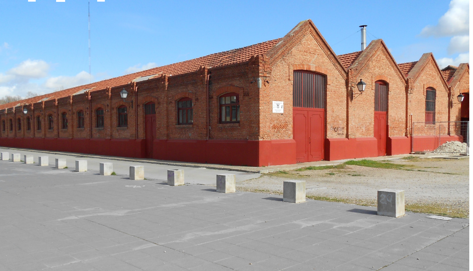
Figura 4.1.1. Imagen general de las naves.
