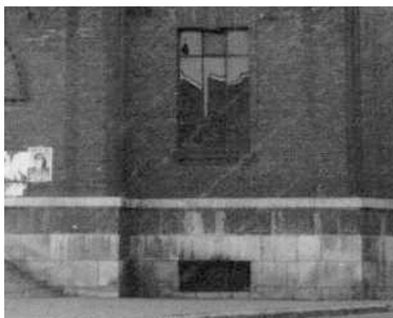
Figura 4.4a.11. Zócalo y fachada principal antes de 1985. Fotografía del archivo de Valladolid.
