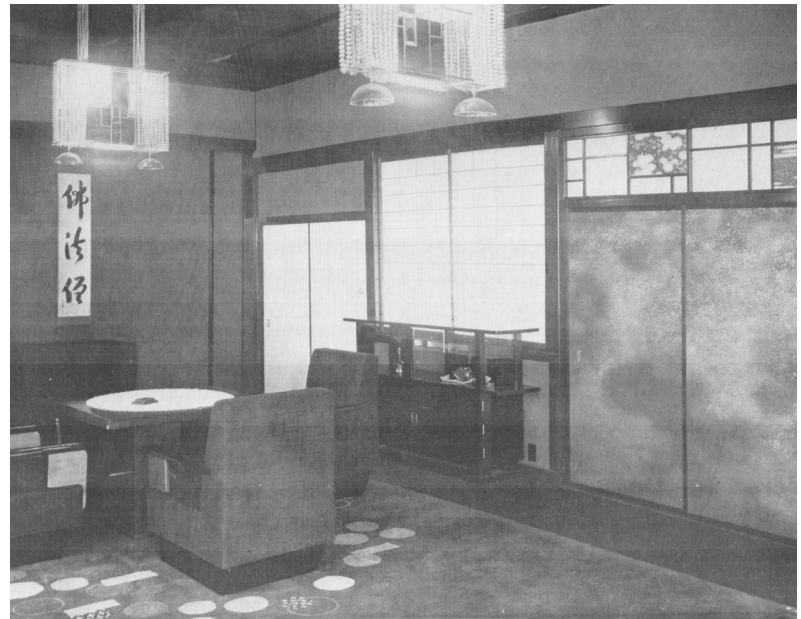
3.03 Sala de estar de la casa Soshokyo
