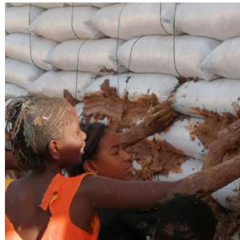
Figura 81: Niños aplicando revestimiento. Fuente: http://www.balouosalo.com/project/tanafcenter.html
