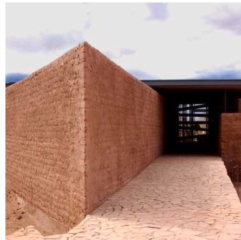
Figura 18: Hotel Tierra de Atacama. Algunas fachadas están construidas con adobe. Fuente: https://www.plataformaarquitectura.cl/cl/02-16425/hotel-tierra-atacama-matias-gonzalez-rodrigo-searle
