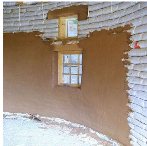
Figura 56: Aplicación de revestimiento interior a base de barro. Fuente: https://ecoinventos.com/earthbag-aprende-a-hacer-una-casa-con-sacos-de-tierra/
