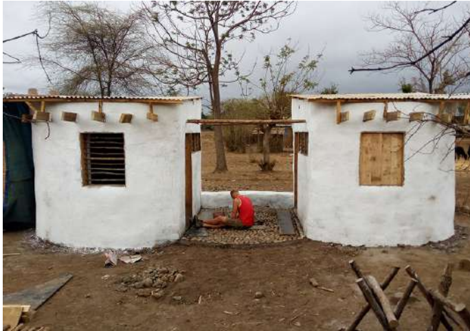
Figura 71: Final del proceso constructivo de la vivienda Maasai. Fuente: http://c-re-aid.org/portfolio/2016/ARI602.html
