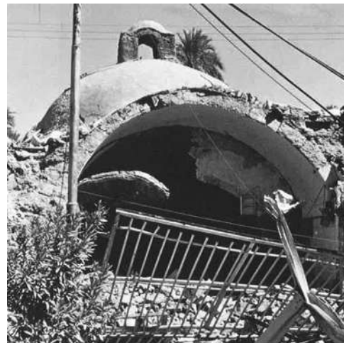
Figura 15: Imagen de los efectos del terremoto de 7.7 en la escala de Richter en Tabas (Irán) en el año 1978. Fuente: Ceramic Houses & Earth Architecture
