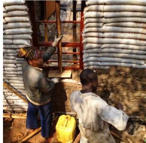
Figura 68: Aplicación de revestimiento. Fuente: http://www.gacollaborative.org/maison-de-masoro
