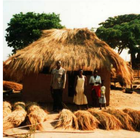
Figura 09: Paja para construir la cubierta en una vivienda tradicional en Zambia. Fuente: https://www.plataformaarquitectura.cl/cl/769065/sobre-por-que-desarrolle-un-banco-de-datos-para-documentar-la-arquitectura-verancular-africana/556efed2e58ece956600022f-why-i-created-a-database-to-document-african-vernacular-architecture-photo
