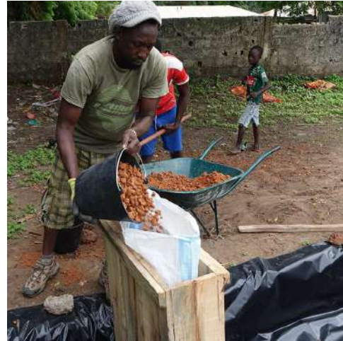
Figura 80: Cimentación. Fuente: http://www.balouosalo.com/project/tanafcenter.html
