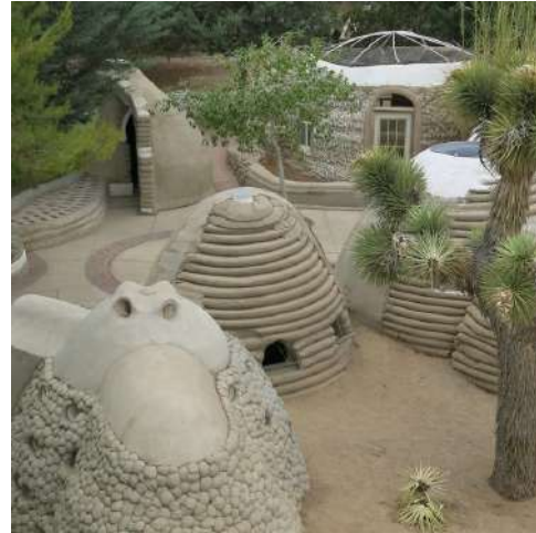
Figura 35: Proceso constructivo "water village". Fuente: https://www.calearth.org/superadobe-structures-calearth
