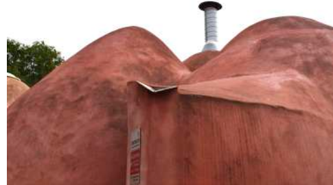
Figura 99: Detalle de elemento de ventilación. Elaboración propia.
