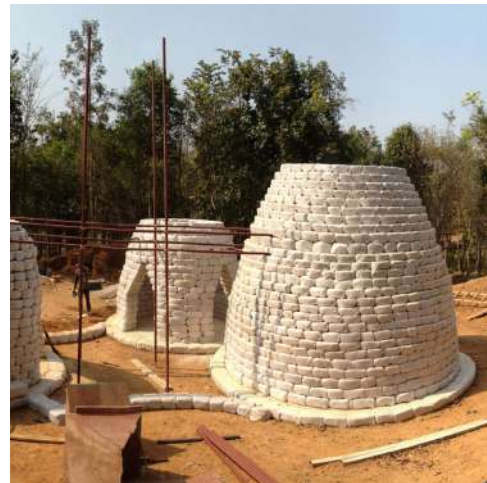
Figura 78: Proceso de colocación de los sacos. Fuente: https://www.archdaily.com/630188/floating-in-the-sky-school-for-orphans-kikuma-watanabe
