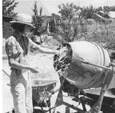
Figura 54: Preparación de la mezcla del revestimiento. Fuente: Ceramic Houses & EarthArchitecture
