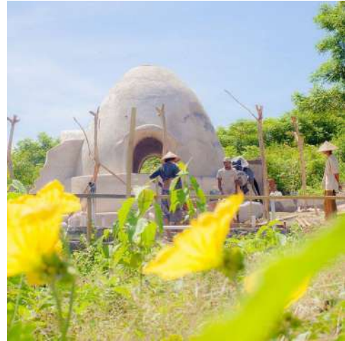
Figura 83: Aplicación de revestimiento exterior. Lombok. Fuente: https://www.archdaily.com/900417/the-dome-lombok-eco-village-team-is-raising-money-to-rebuild-city-after-devastating-earthquake
