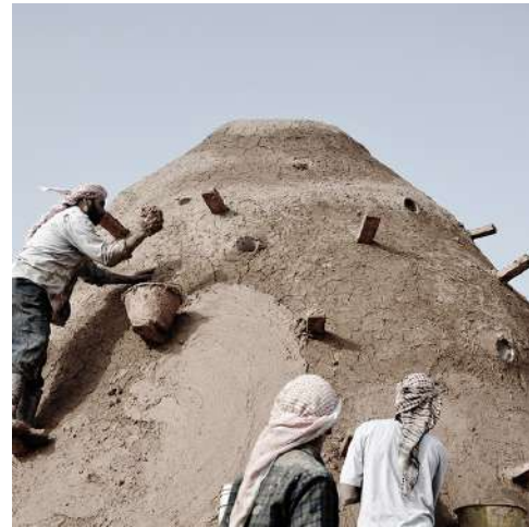
Figura 73: Aplicación del revestimiento. Colegio en Za'atari. Fuente: http://ea-hr.org/zaatari-classroom/
