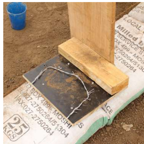
Figura 48: Placa de anclaje de madera para colocar las futuras carpinterías. Imagen original obtenida de: http://c-re-aid.org/portfolio/2016/ARI602.html
