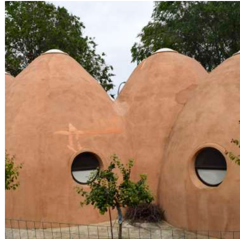
Figura 102: Reparaciones en el paramento. Elaboración propia.
