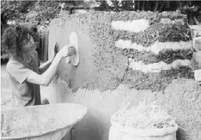
Figura 53: Aplicación del revestimiento exterior de barro y paja con una llana. Fuente: Ceramic Houses & Earth Architecture
