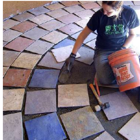
Figura 59: Colocación de un suelo de baldosas cerámicas. Imagen original obtenida de: https://ecoinventos.com/earthbag-aprende-a-hacer-una-casa-con-sacos-de-tierra/
