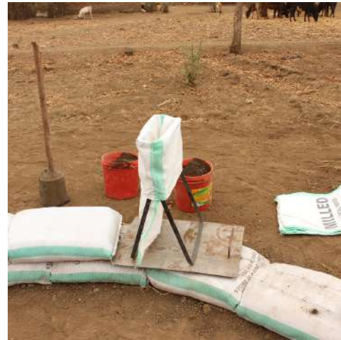
Figura 41: Elementos auxiliares (sujetador, deslizador, latas con tierra y pisón). Fuente: http://c-re-aid.org/portfolio/2016/AR1602.html
