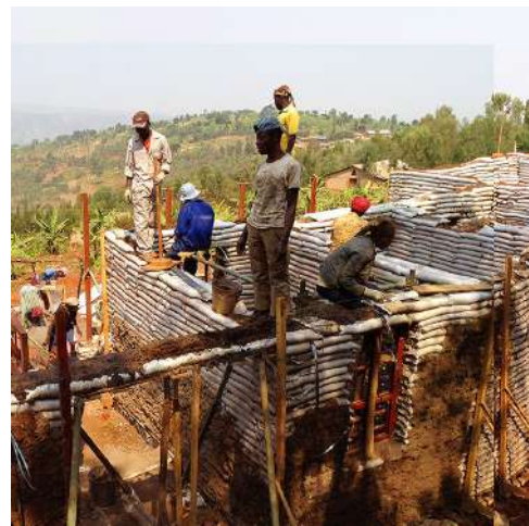
Figura 69: Proceso constructivo. Masoro. Fuente: http://www.gacollaborative.org/maison-de-masoro
