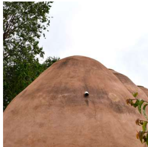
Figura 100: Detalle de elemento de ventilación del baño. Elaboración propia.
