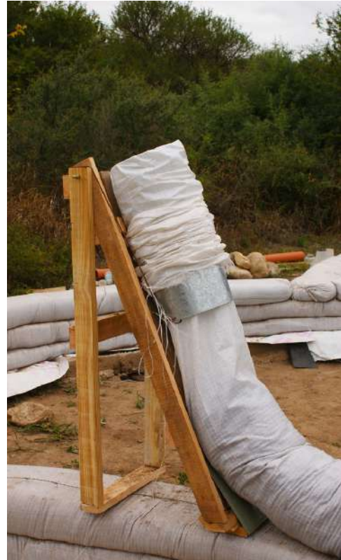
Figura 46: Proceso de llenado de un saco donde aparecen dos elementos el sujetador de sacos y el deslizador. Fuente: https://www.taringa.net/+ecologia/me-hice-una-casa-de-superadobe-actualizado_u2mgz
