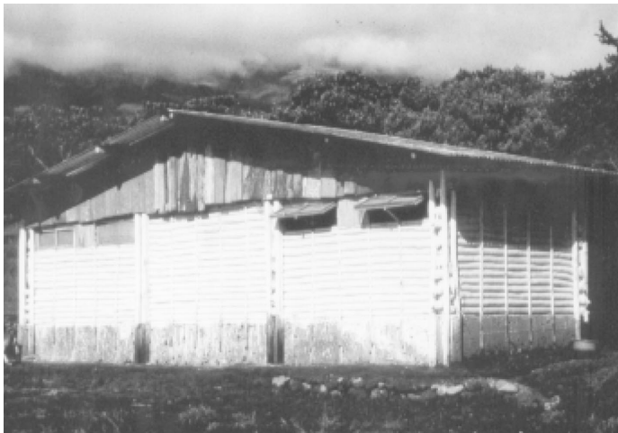
Figura 26: Imagen exterior de la vivienda antisísmica en Guatemala, 1978. Fuente: Ceramic Houses & Earth Architecture
