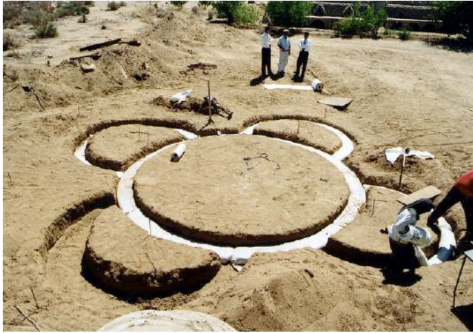
Figura 45: Imagen del proceso de cimentación utilizando sacos de tierra. Fuente: https://dornob.com/cal-earth-reopens-to-provide-low-cost-eco-building-inspiration/
