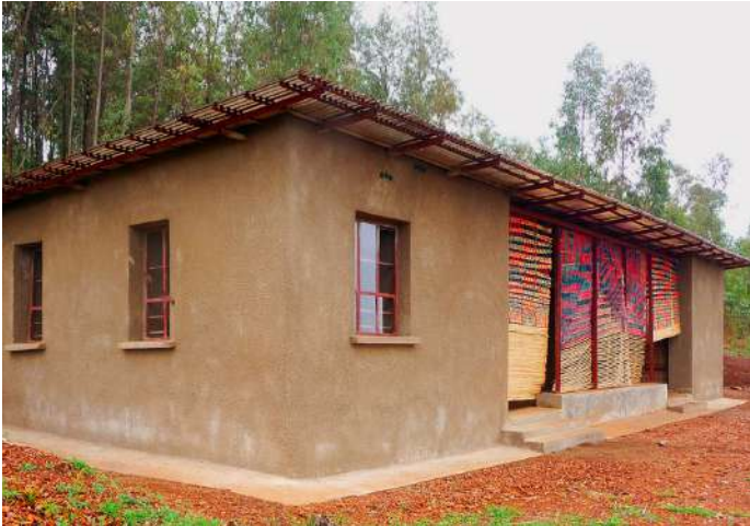
Figura 70: Resultado final de la vivienda en Masoro. Fuente: http://www.gacollaborative.org/maison-de-masoro
