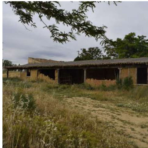
Figura 13. Construcción tradicional en Tierra de Campos
