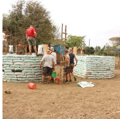
Figura 72: Proceso constructivo de la vivienda Maasai. Fuente: http://c-re-aid.org/portfolio/2016/ARI602.html
