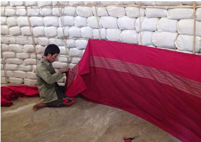
Figura 77: Colocación de las telas. Fuente: https://www.archdaily.com/630188/floating-in-the-sky-school-for-orphans-kikuma-watanabe
