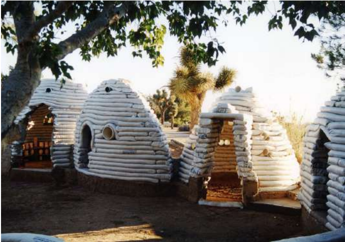
Figura 34: Proceso constructivo "water village". Fuente: https://www.calearth.org/superadobe-structures-calearth
