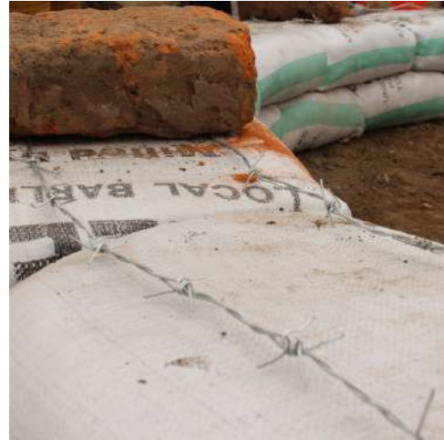
Figura 39: Detalle de colocación de las dos hiladas de alambre. Fuente: http://c-re-aid.org/portfolio/2016/ARI602.html
