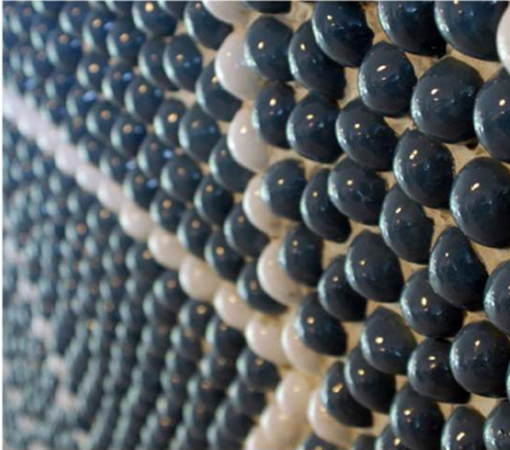
Revestimiento utilizado en paredes, medias esferas hechas de cerámica
