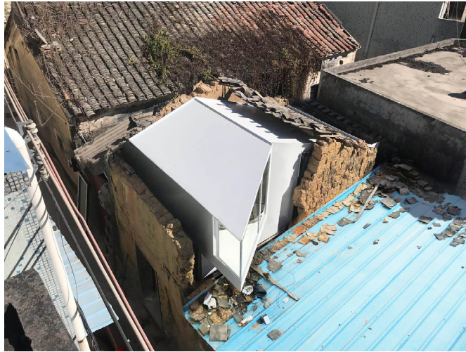
Figura 12: Vivienda en una casa en ruinas en China.
