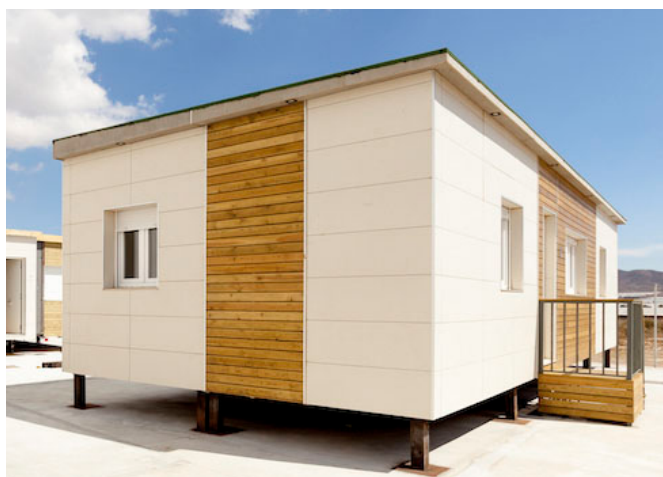
Figura 5: Una de las viviendas construidas por Custom Home.
