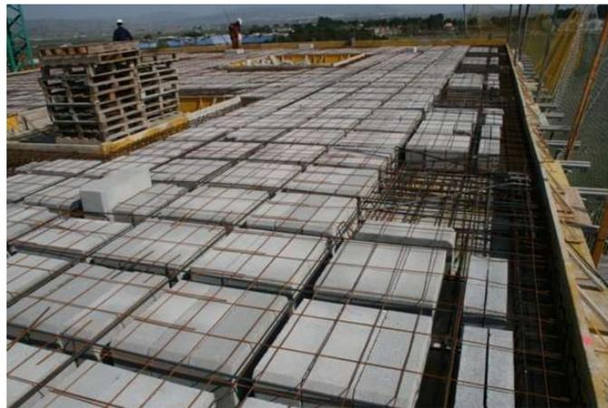
Figura 7. Forjado bidireccional. Fuente: Viguetas Encinas
