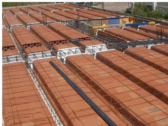
Figura 6. Forjado unidireccional. Fuente: Viguetas Encinas
