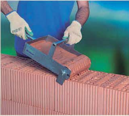
5 APLICACIÓN DE MORTERO
