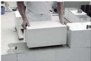
Colocación de los bloques prefabricados de hormigón celular
