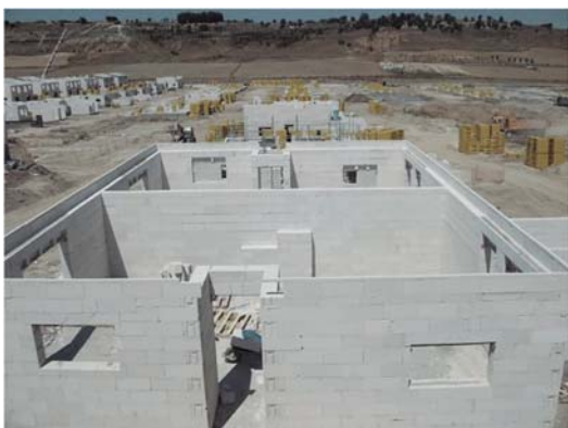
Construcción de una vivienda con Bloques de hormigón celular
