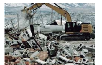
Demolición. Fuente: http://www.hildebrandt.cl/generacion-de-escombros-y-residuos-de-la-construccion/
