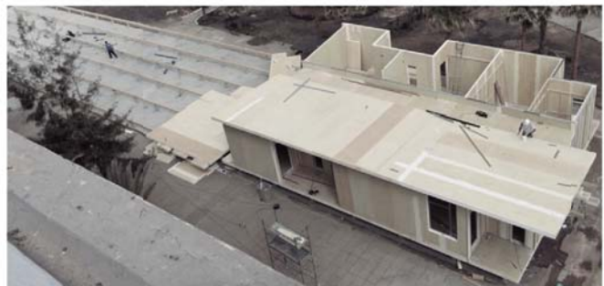
Vivienda realizada con Compoplak. Fuente: http://www.modularproyectos.es/estructura-completa-de-6-habitaciones-en-modulo-sanitario/
