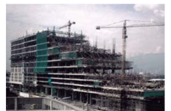
Obra. Fuente: https://www.360enconcreto.com/blog/detalle/edificio-direccion-general-bancolombia-proyecto-lead-en-colombia
