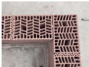
Ejecución de cerramiento con termoarcilla.
