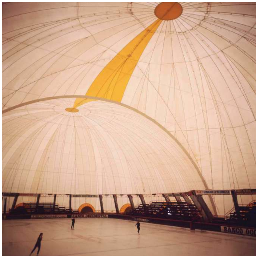
Figura 222. Vista interior de la pista de patinaje bajo la gran cúpula hinchable.
