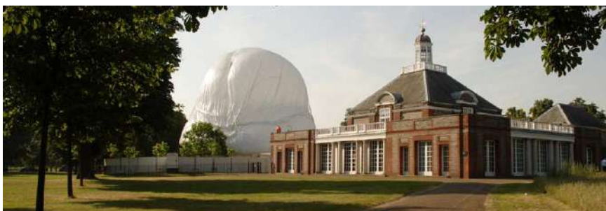
Figura 249. Proceso de erección del pabellón.
