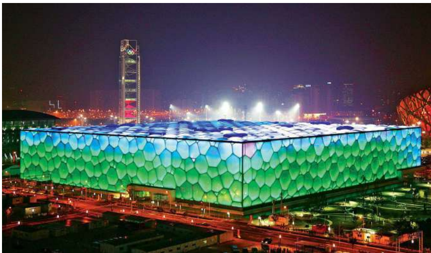
Figura 281. Vista nocturna del cerramiento de ETFE del Centro Acuático Nacional de Beijing (China)
