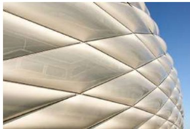
Figura 270. Fachada de ETFE. Estadio Allianz Arena en Munich.
