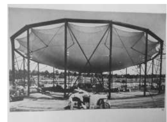
Figura 37. Proceso de montaje de la cubierta neumática.
