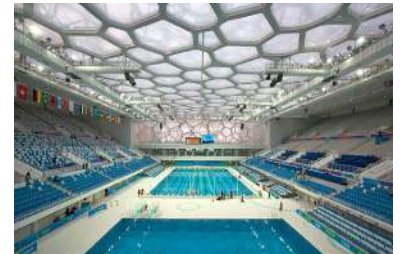
Figura 280. Cubierta de ETFE del Centro Acuático Nacional de Beijing (China).
