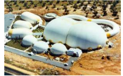
Figura 217. Vista aérea del Hielotrón en Sevilla.
