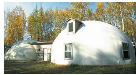
Figuras 286 y 287. Viviendas Monolithic Dome.
