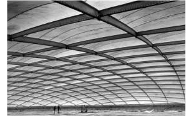
Figura 124. Vista interior de la cubierta neumática.
