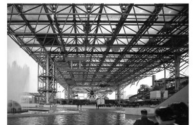
Figura 142. Estructura de la cubierta.
