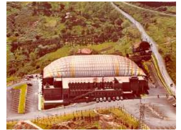
Figura 229. Vista aérea de la cubierta.
