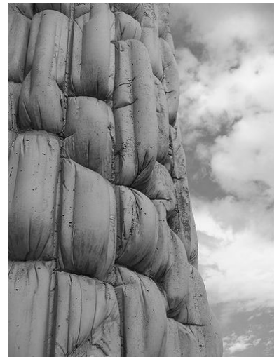
Figura 167. Encofrado flexible en el estudio de Miguel Fisac en Madrid. 1971.
