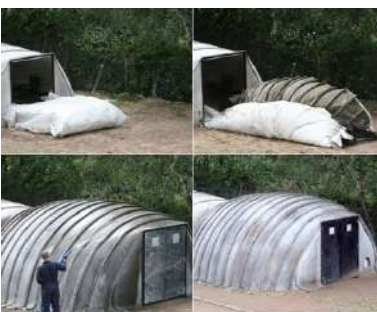
Figura 288. Proceso de montaje de Refugio Concrete Canvas
