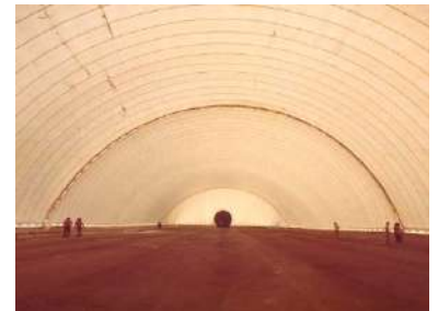
Figuras 241 y 242. Cubiertas industriales hinchables
