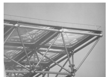
Figura 144. Detalle del techo neumático.
