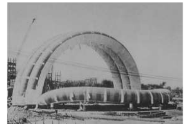
Figura 134. Proceso de montaje.
