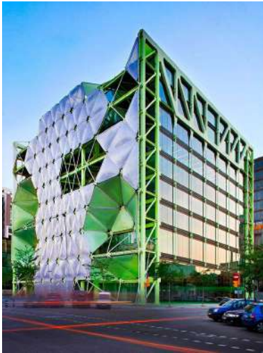
Figura 277. Vista exterior de la fachada de ETFE del edificio Media-Tic en Barcelona.
