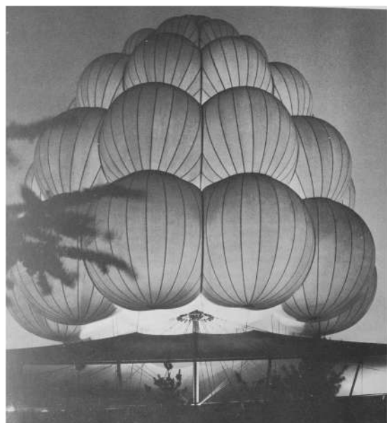
Figuras 46 y 47. Vista interior y exterior de la cúpula neumática.
