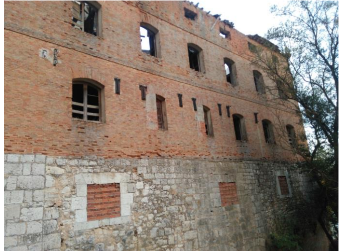
Fig 9. Detalle de los anclajes metálicos
