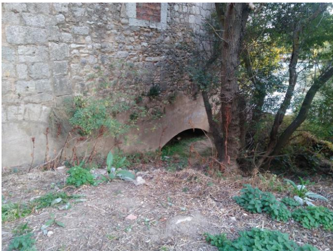
Fig 8. Estado actual de los túneles
