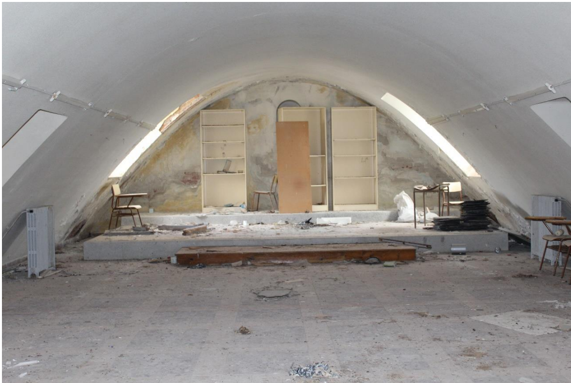
Ilustración 41. Bóveda de cañón parabólica sobre "transepto". Fuente: foto del autor.
