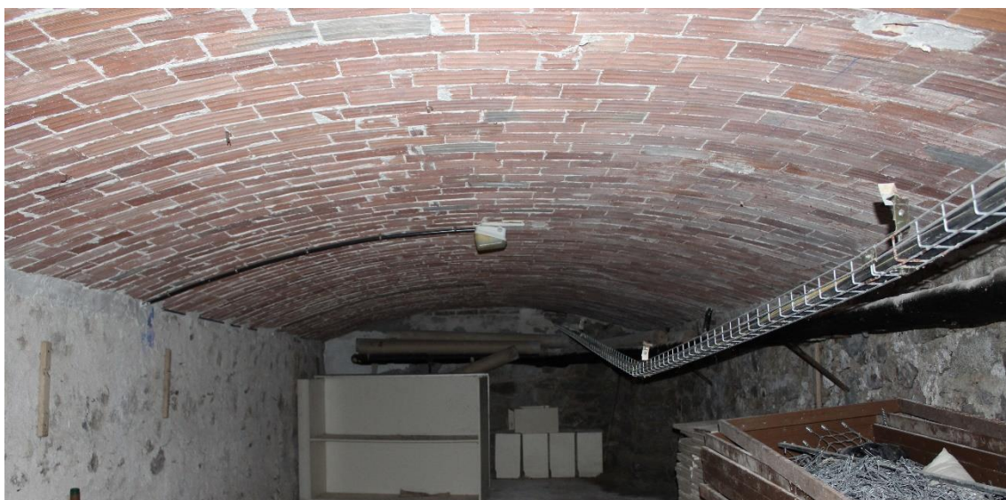
Ilustración 33. Bóveda circular rebajada en planta sótano. Fuente: foto del autor.
