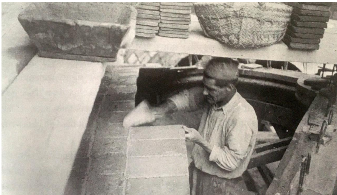
Ilustración 13. Albañil colocando piezas del senzillado. (Truño, 2004, pág. 21)
