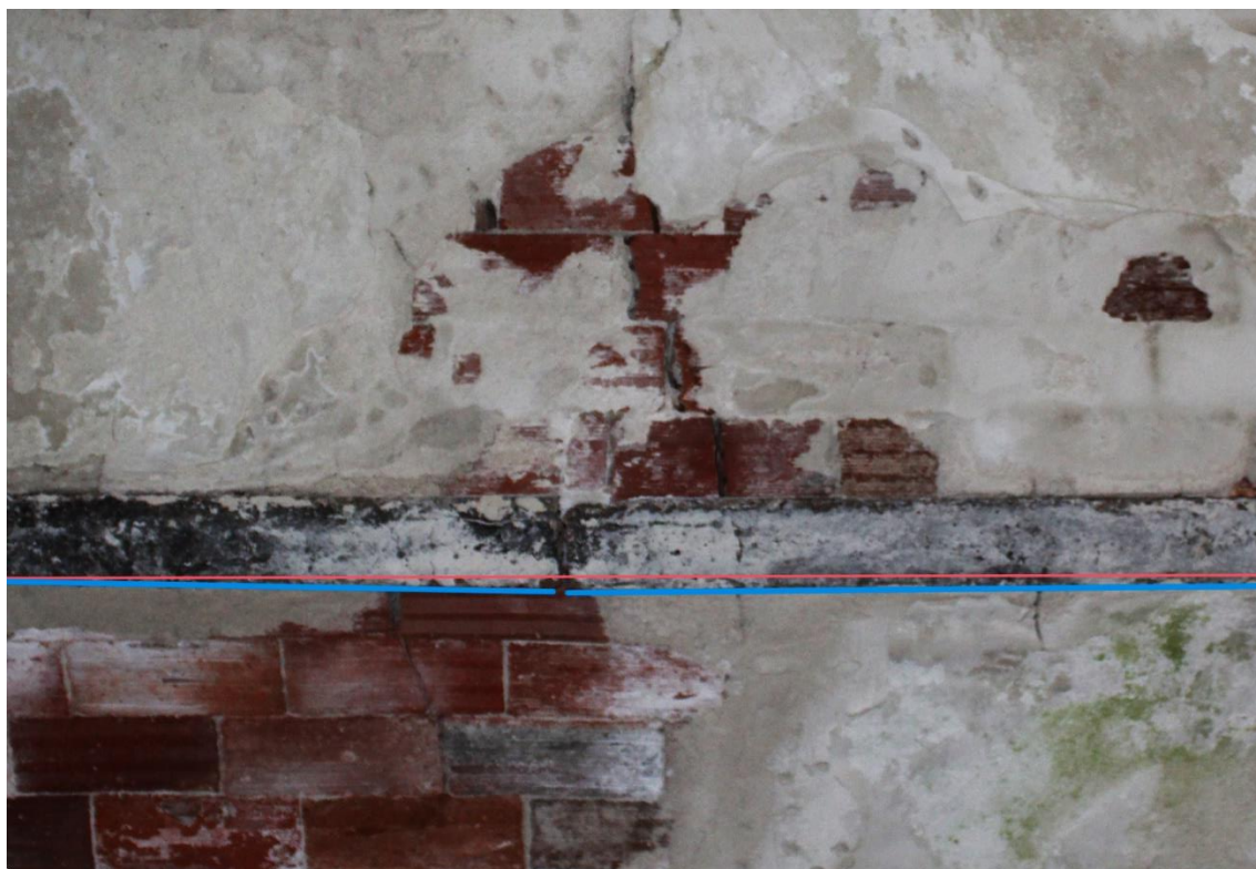
Ilustración 43. Ampliación. Vigüeta partida y desplazada respecto de la referencia del láser. Fuente: foto del autor.
