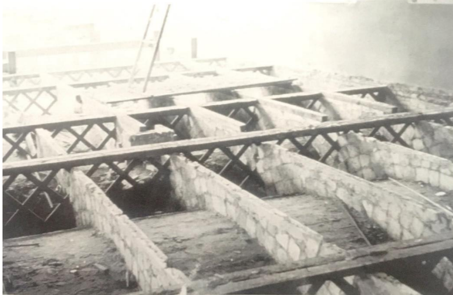
Ilustración 19. Formación de superficie planta mediante lengüetas. (Truño, 2004, pág. xlix)
