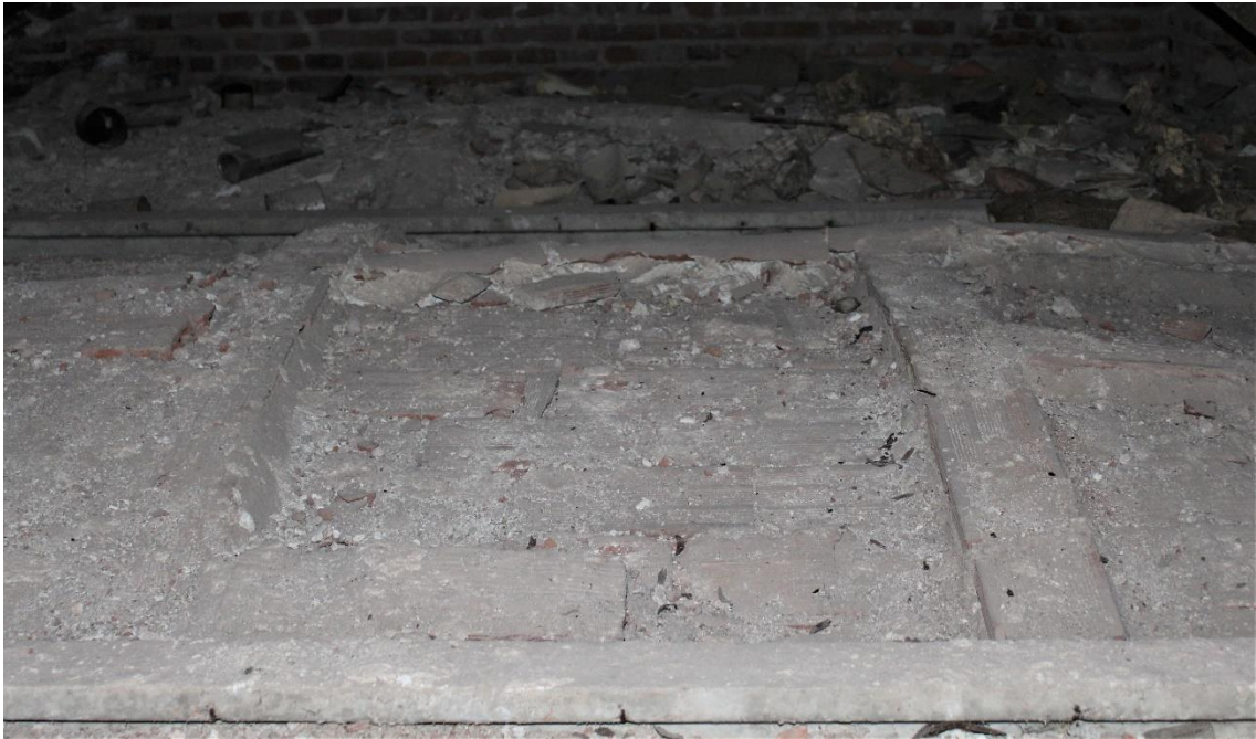
Ilustración 24. Parte superior de una bóveda esquifada con su segunda vuelta incompleta. Fuente: foto del autor.
