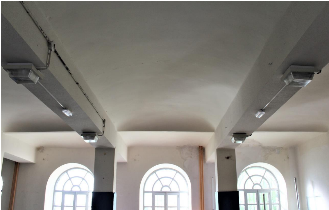
Ilustración 32. Bóveda esquifada sobre viga y pilar en planta baja. Fuente: foto del autor.
