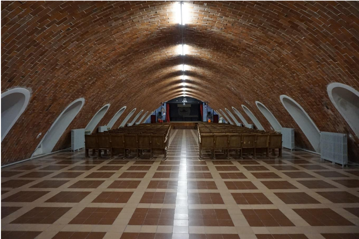
Ilustración 40. Bóveda de cañón parabólica en salón de actos. Fuente: foto de Javier Ropero Giralda.
