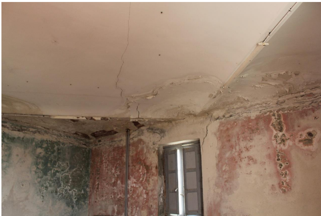
Ilustración 29. Bóveda sobre cuadrado de viguetas de planta segunda en la torre oeste. Fuente: foto del autor.
