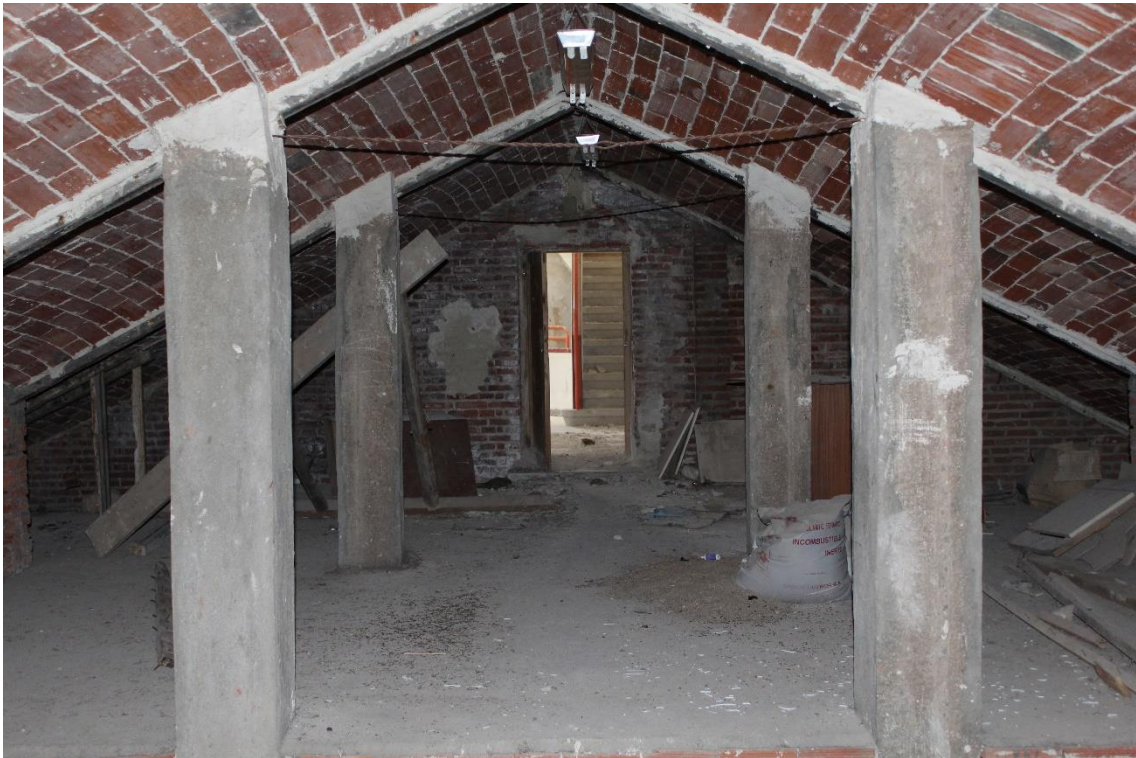
Ilustración 35. Bóveda circular rebajada sobre viguetas, pilares y machones. Fuente: foto del autor.
