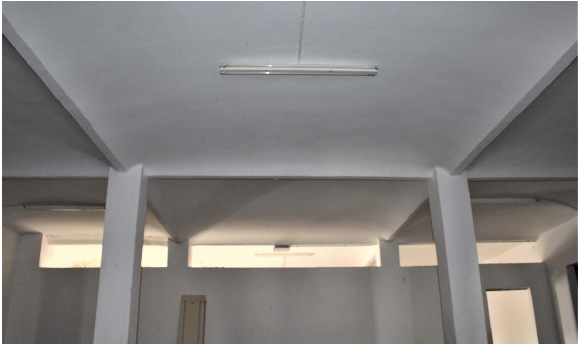
Ilustración 31. Bóvedas esquifadas sobre vigueta y pilar en el rellano de planta primera. Fuente: foto del autor.
