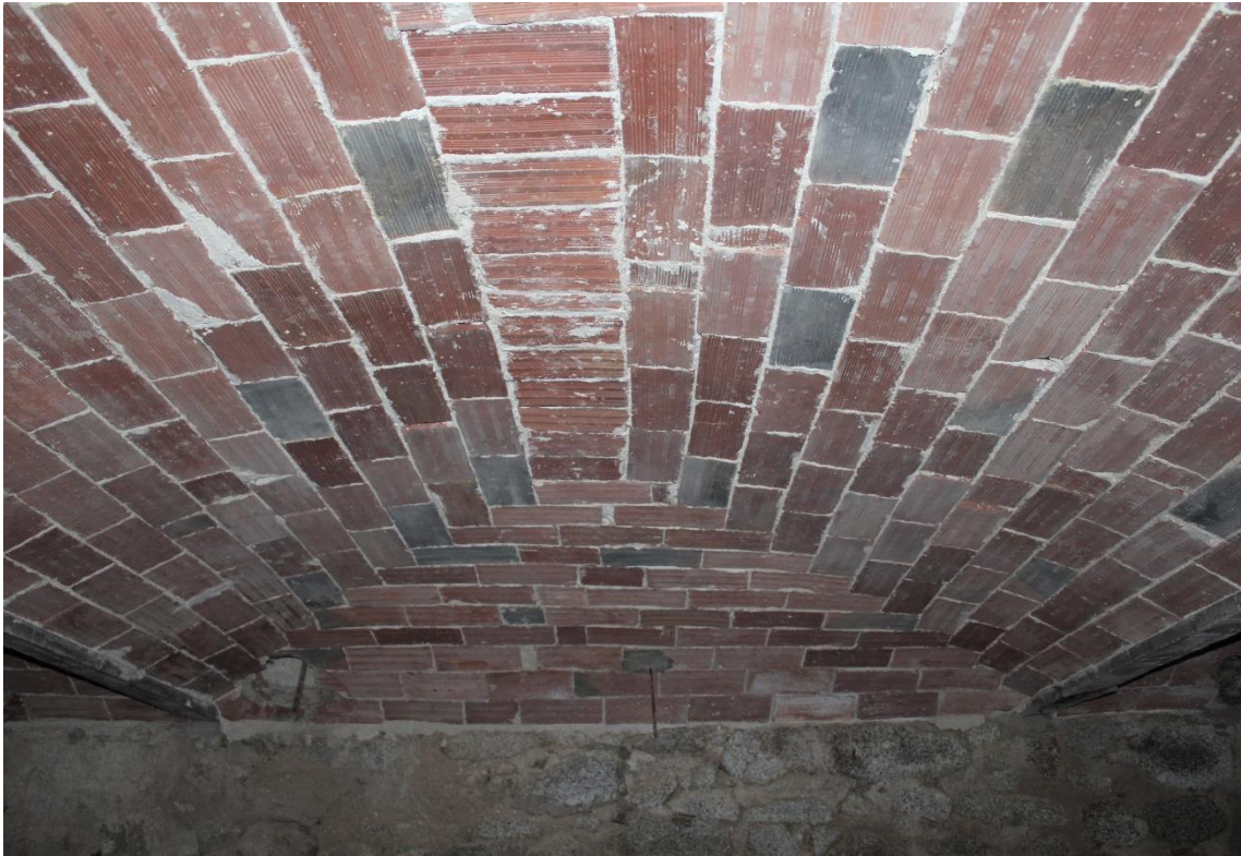
Ilustración 28. Bóveda esquifada sobre viguetas de planta sótano. Fuente: foto del autor.
