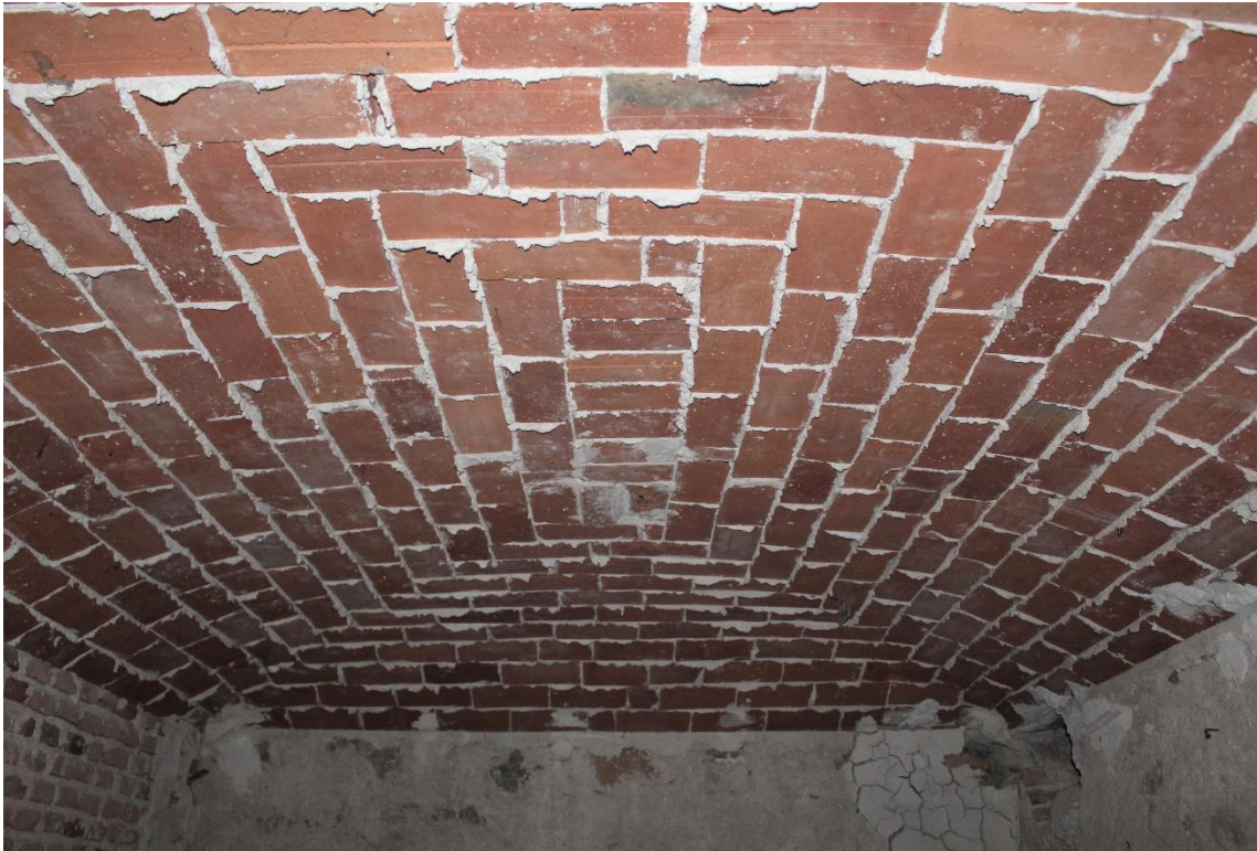
Ilustración 26. Bóveda esquifada sobre muros de planta sótano. Fuente: foto del autor
