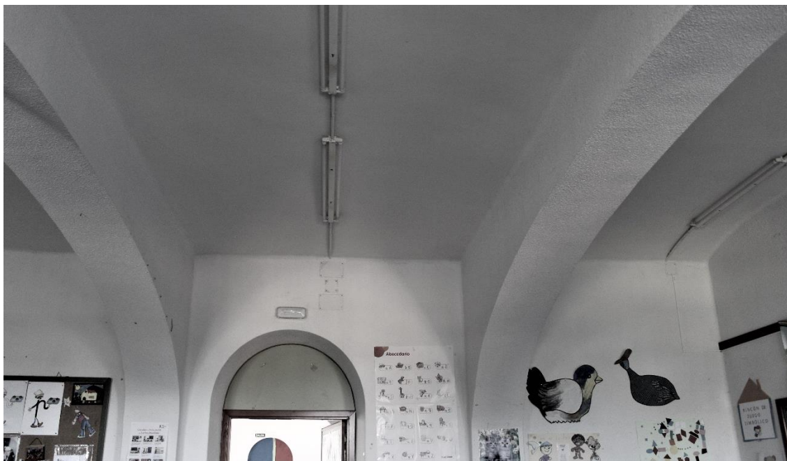
Ilustración 27. Bóveda esquifada sobre arcos de planta baja. Fuente: foto del autor.
