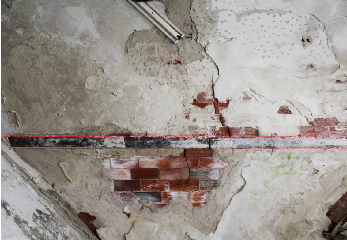
Ilustración 42. Vigüeta agrietada con nivel láser vertical. Planta primera. Fuente: foto del autor.
