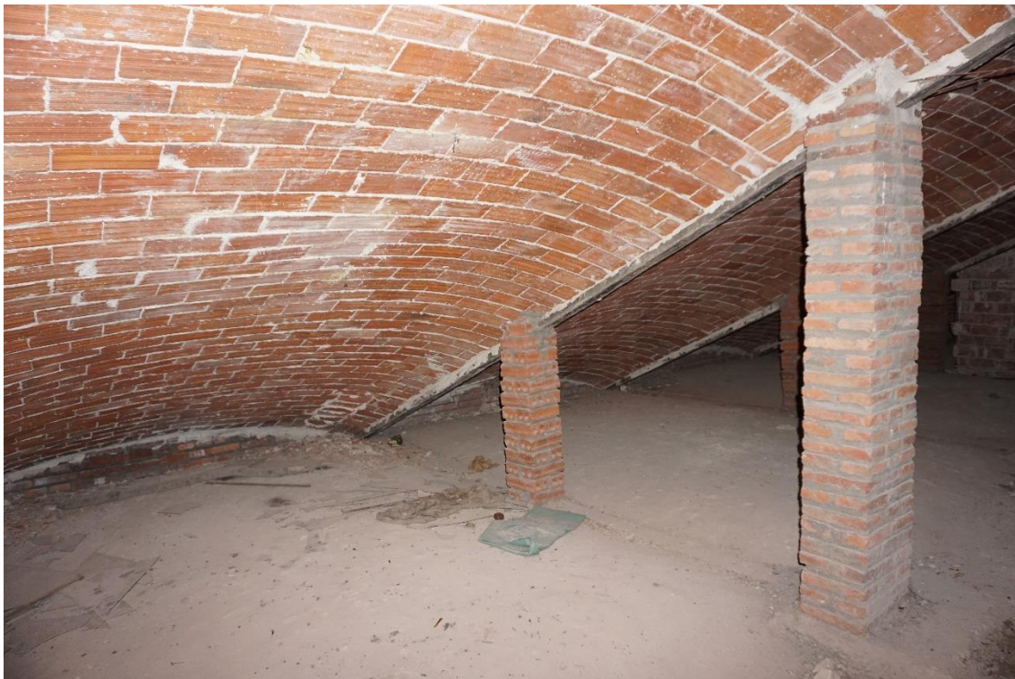
Ilustración 36. Bóveda circular rebajada sobre vigueta y machones. Fuente: foto del autor.
