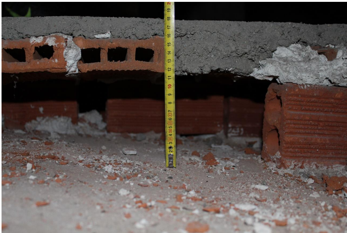
Ilustración 25. Espesor del tablero horizontal sobre las lengüetas. Fuente: foto del autor.
