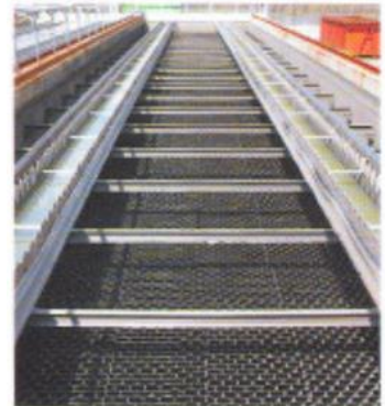
Figura 3. Decantador lamelar
